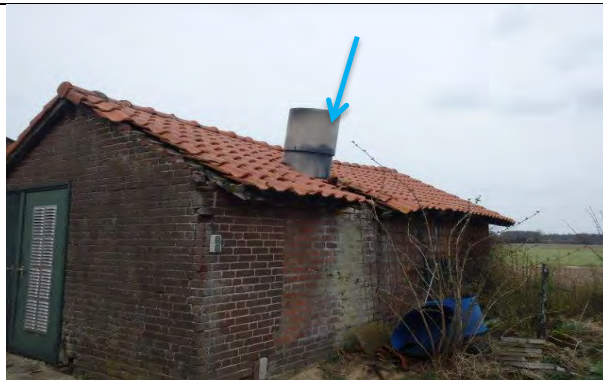
Foto nr. 15, schuur voorzien van pannendak + kunststof afvoer buis geen asbest
