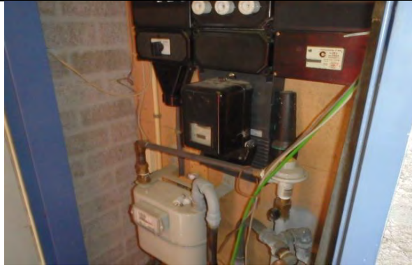
Foto nr 17 meterkast geen asbest
