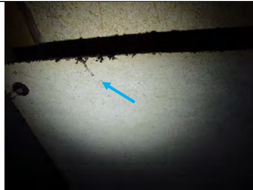
Foto nr. 10, plaat boven deur schuur 2 13 stuks identiek M 1 geen asbest
