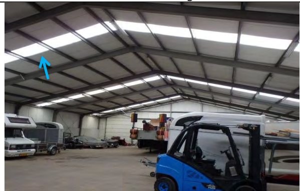
Foto nr. 14 nieuwe schuur damwandprofielen met isolatieplaten geen asbest
