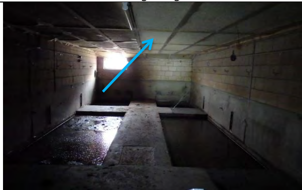
Foto nr. 13 hout/vezel cement platen geen asbest
