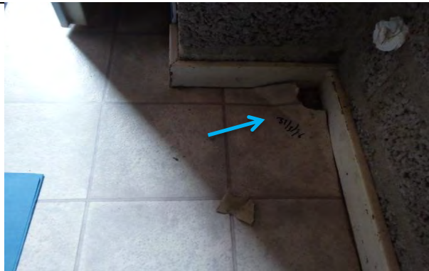
Foto nr. 11, vloerbedekking/zeil geen asbest
