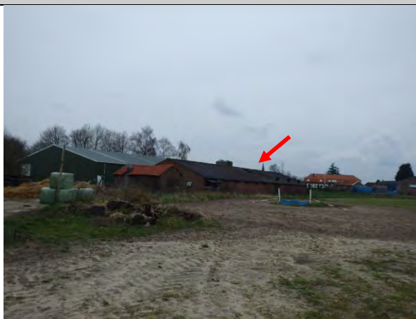
Foto nr. 7, Golfplaten van schuur 3, M4, asbesthoudend
