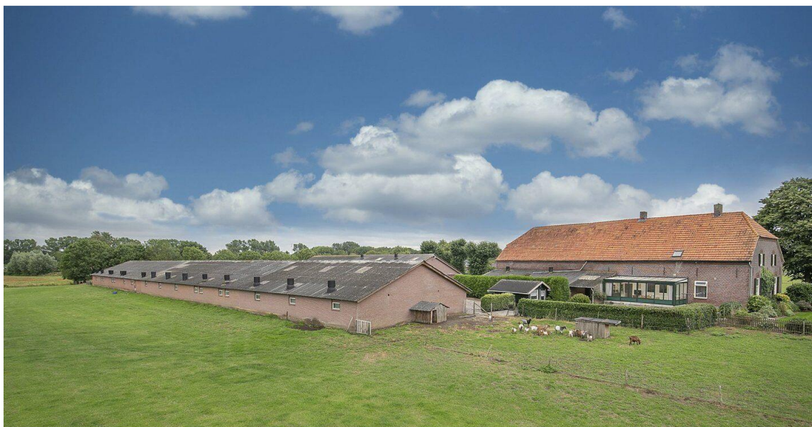
Bestaande situatie Boltschestraat 2
