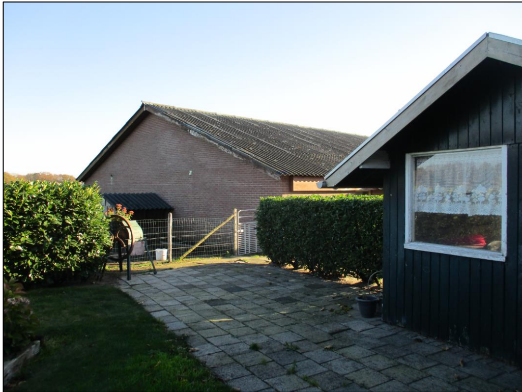
Figuur 1 De kleine schuur en lange varkenstal.
