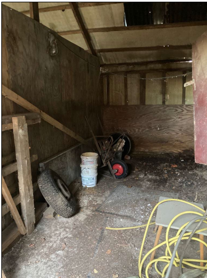
• Afbeelding 7: binnezijde te slopen in schuur 2
