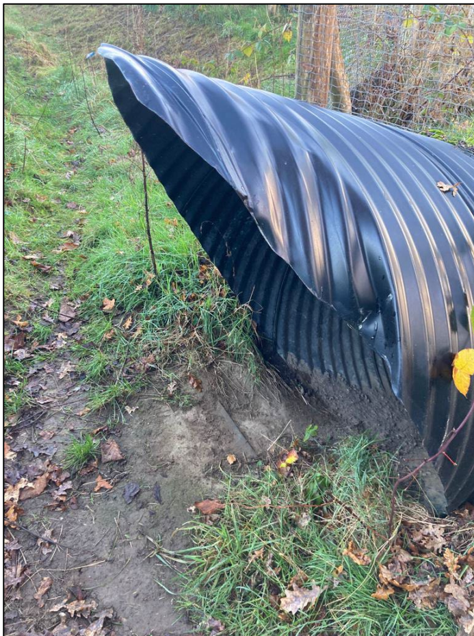
• Afbeelding 17: ecodeuct onder het spoor
