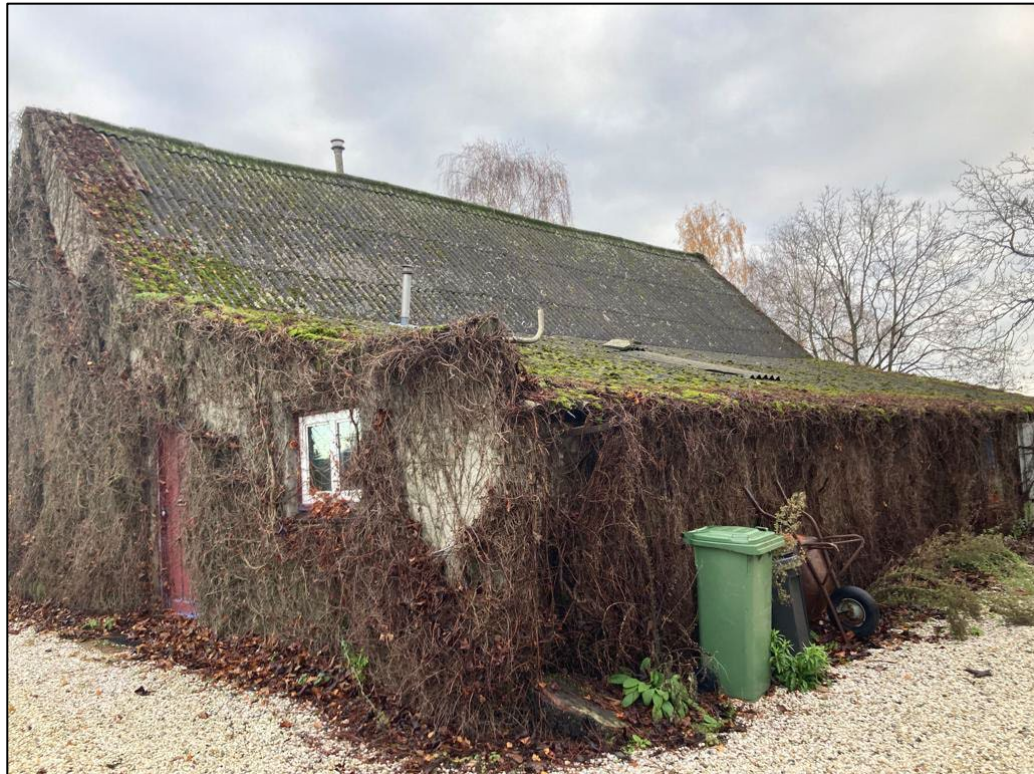
• Afbeelding 3: de te slopen schuur
