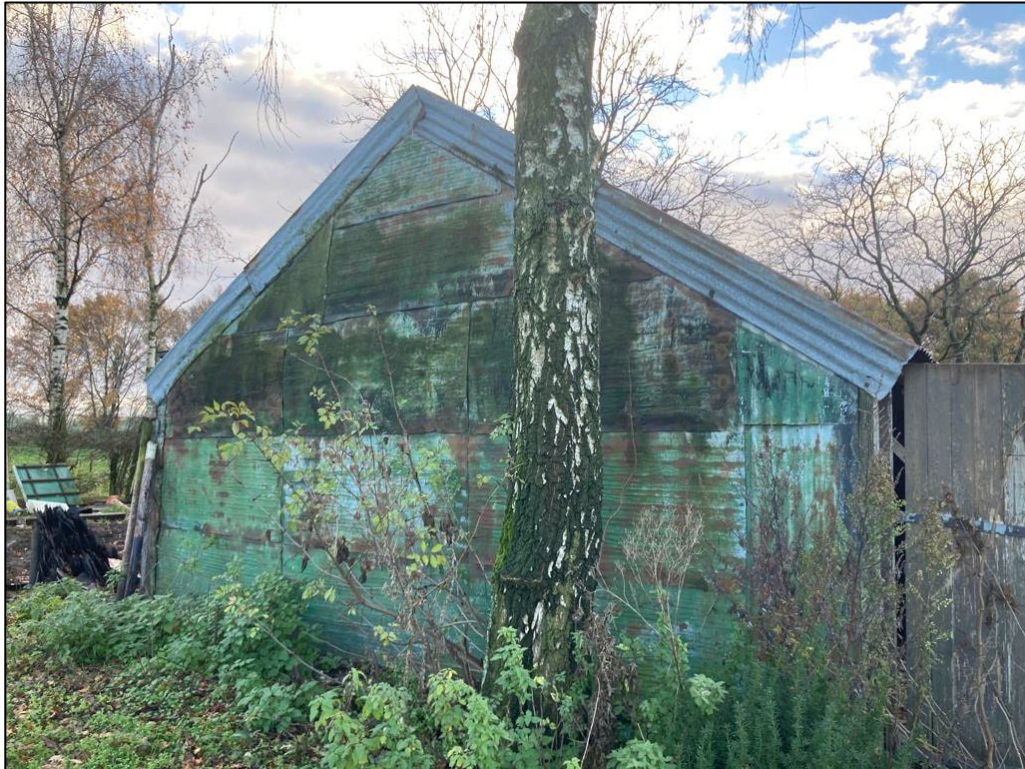
• Afbeelding 10: te slopen schuur 2 geheel stalen profiel platen
