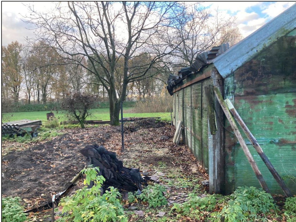
• Afbeelding 11: zijkant te slopen schuur 2
