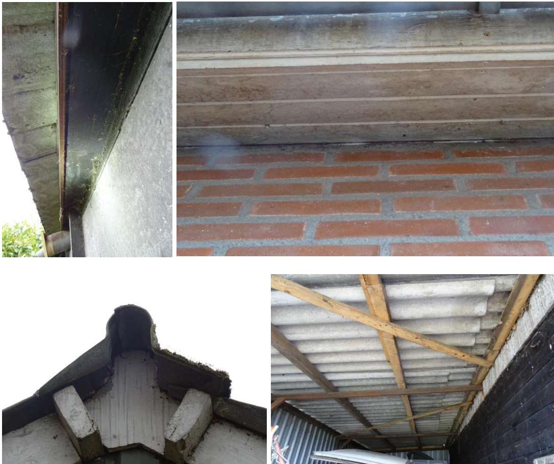
Afbeelding 15 t/m 18: afwezigheid van mogelijke verblijfflocaties van vleermuizen in de te slopen bebouwing. Bron: BNL advies. Datum: 08-04-2022
