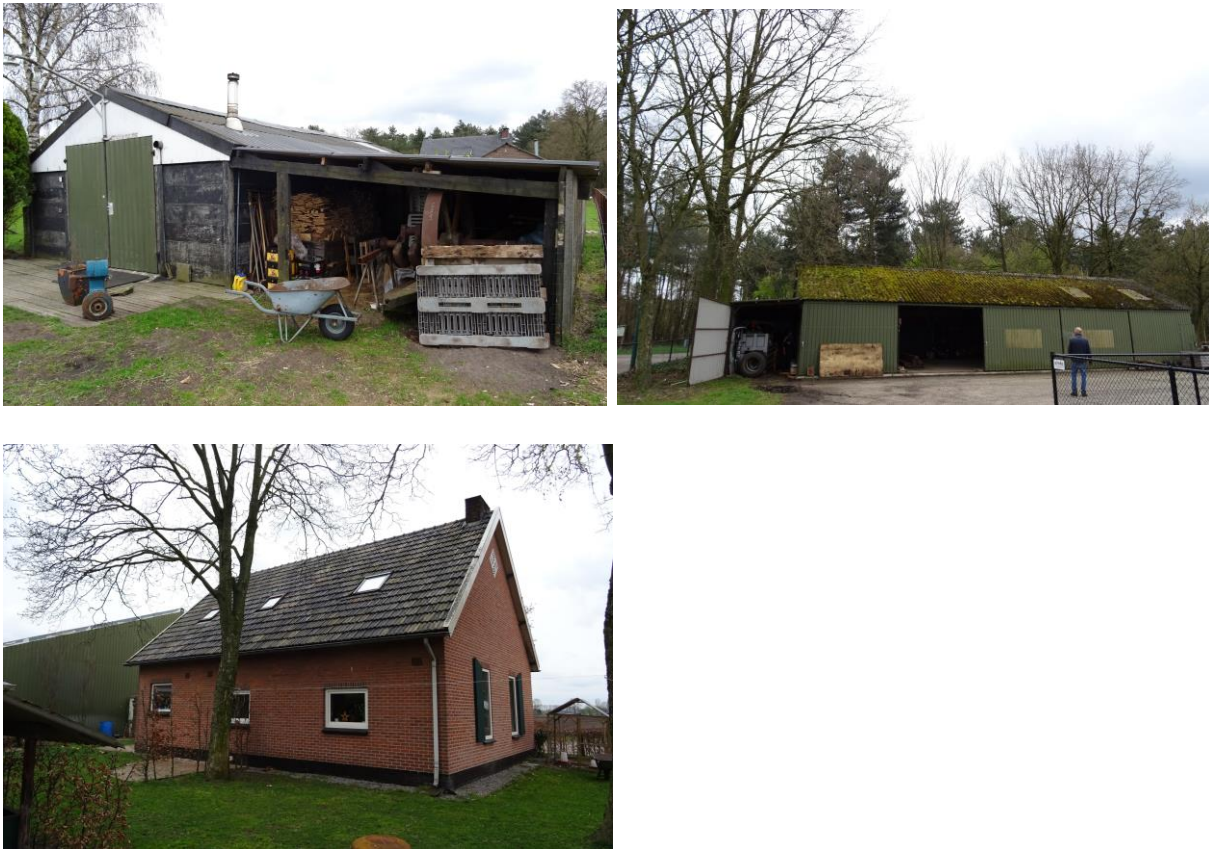
Afbeelding 3, 4 en 5: te slopen bebouwing. Bron: BNL advies. Datum: 08-04-2022
