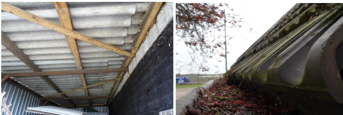
Afbeelding 6 t/m 9: te slopen bebouwing. Bron: BNL advies. Datum: 08-04-2022
