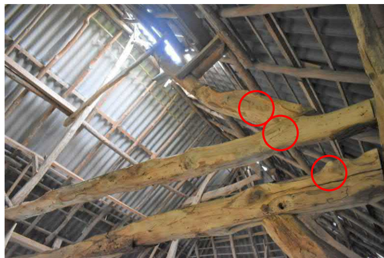
Telmerk I in linkerzijbeuk.
