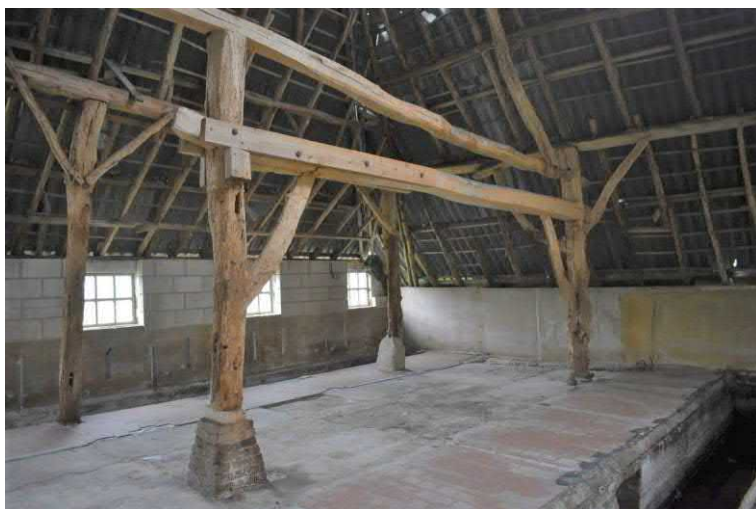
Ankerbalk-dekbalk gebint met dubbele ankerbalk zonder telmerken.
