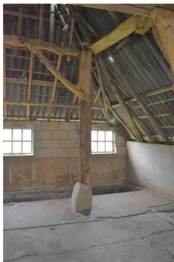
Dekbalkgebint zonder telmerken. Dekbalkgebint zonder telmerken.
