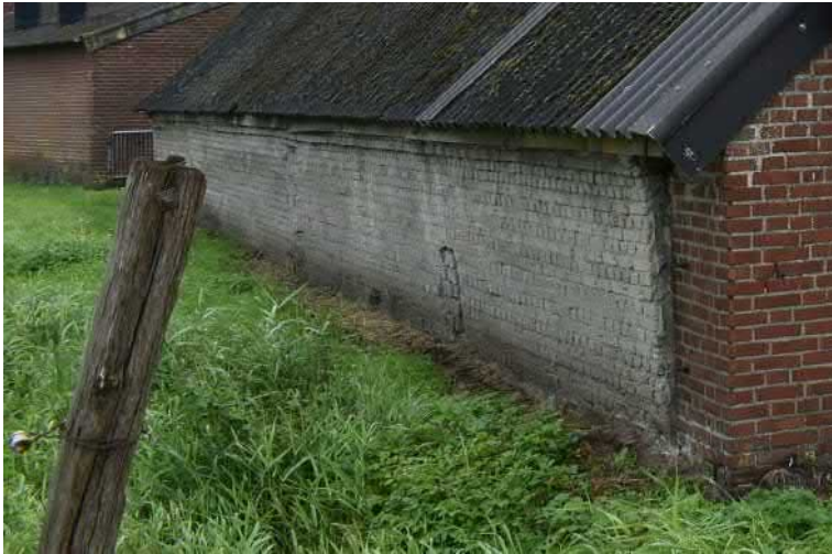
Linkerzijgevel met rechts een smalle penant opgetrokken uit rode baksteen in wild verband.
