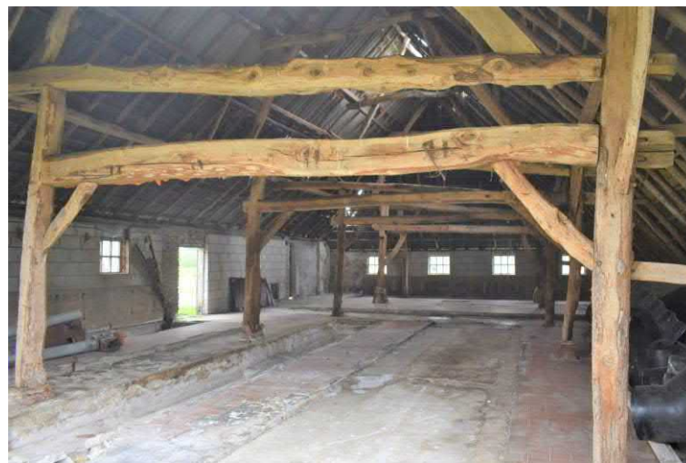
Vierde ankerbalk-dekbalk gebint met dubbele ankerbalk.
