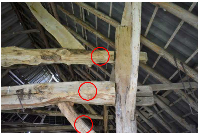
Telmerk II in linkerzijbeuk.
