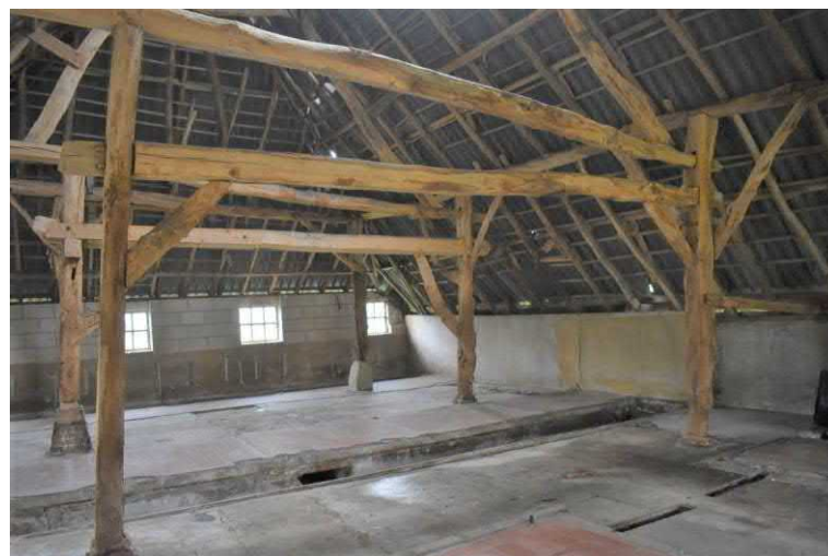
Tweede ankerbalk-dekbalk gebint met dubbele ankerbalk.
