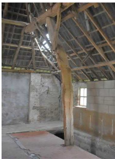
Dekbalkgebint zonder telmerken. Dekbalkgebint zonder telmerken.
