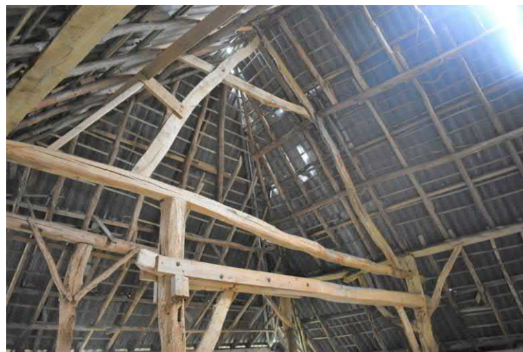
Dakconstructie ankerbalk-dekbalk gebint met dubbele ankerbalk.
