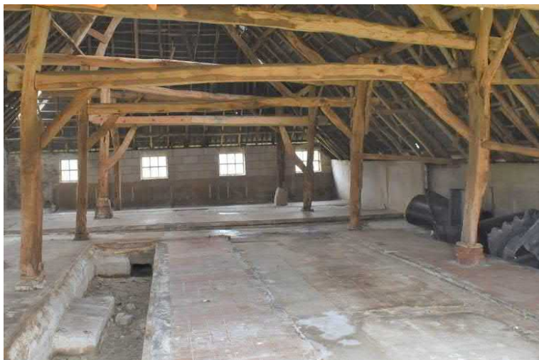
Derde ankerbalk-dekbalk gebint met dubbele ankerbalk.
