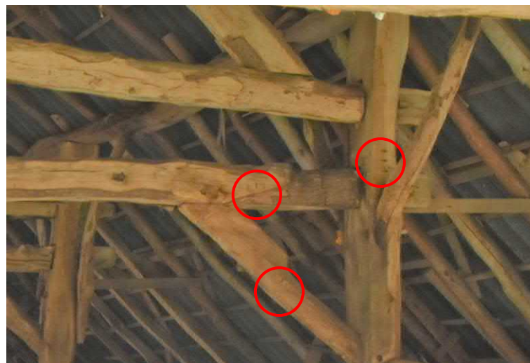
Telmerk III in linkerzijbeuk.
