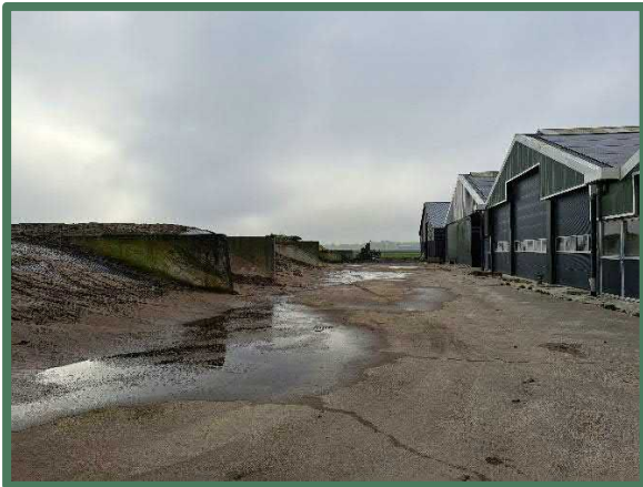
Achterzijde loodsen en open opslag Peelstraat 11
