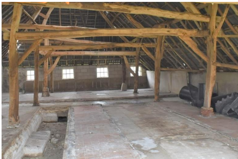
Derde ankerbalk-dekbalk gebint met dubbele ankerbalk.
