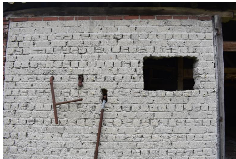
Achtergevel opgebouwd uit cementsteen in kruisverband uit vermoedelijk de eerste kwart van de twintigste eeuw.
