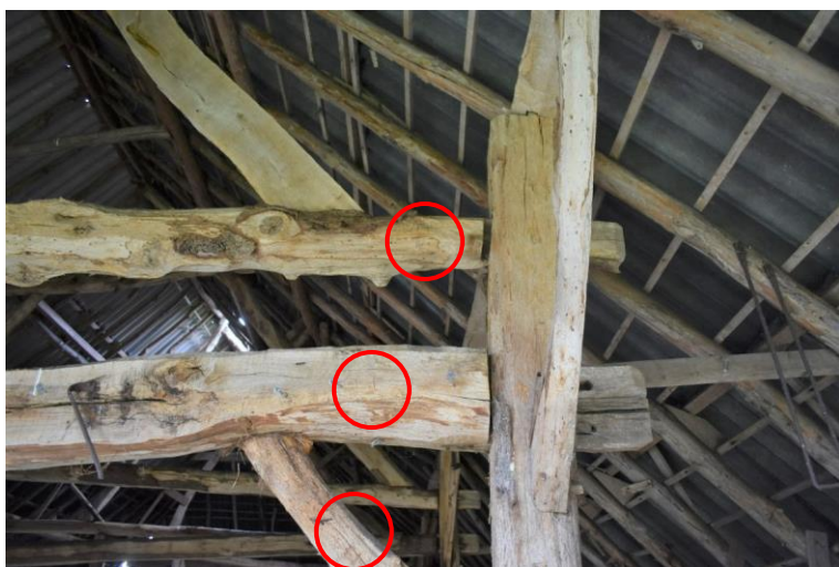
Telmerk II in linkerzijbeuk.
