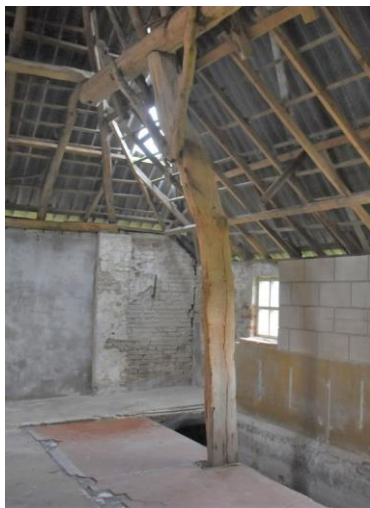
Dekbalkgebint zonder telmerken. Dekbalkgebint zonder telmerken.
