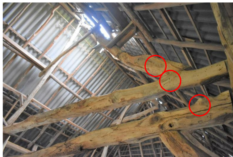
Telmerk I in linkerzijbeuk.
