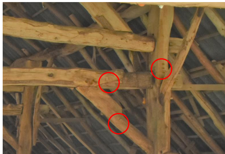
Telmerk III in linkerzijbeuk.
