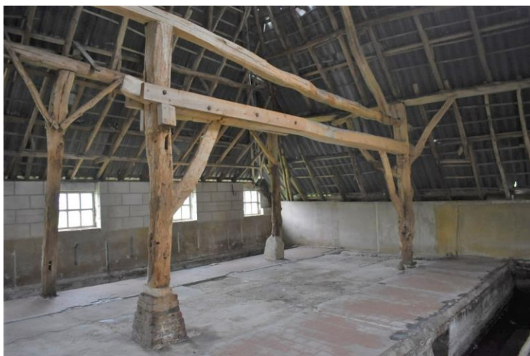
Ankerbalk-dekbalk gebint met dubbele ankerbalk zonder telmerken.
