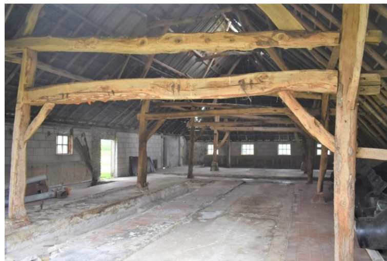
Vierde ankerbalk-dekbalk gebint met dubbele ankerbalk.
