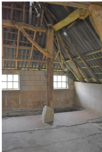
Dekbalkgebint zonder telmerken. Dekbalkgebint zonder telmerken.
