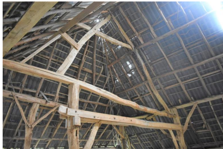
Dakconstructie ankerbalk-dekbalk gebint met dubbele ankerbalk.
