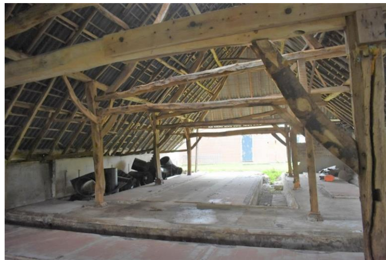
Constructie vanaf de voorgevel gezien.
