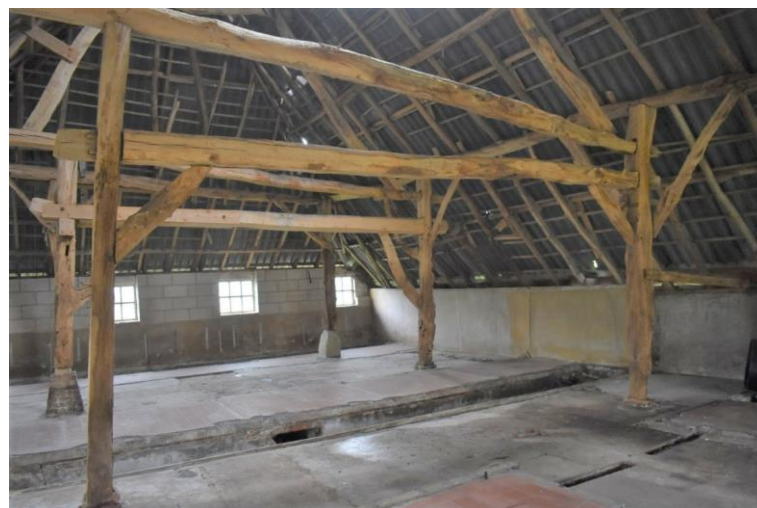
Tweede ankerbalk-dekbalk gebint met dubbele ankerbalk.
