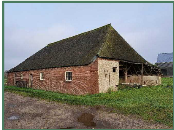
Cultuurhistorische schuur Peelstraat 15
