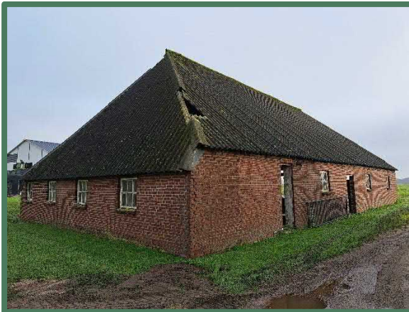
Cultuurhistorische schuur Peelstraat 15
