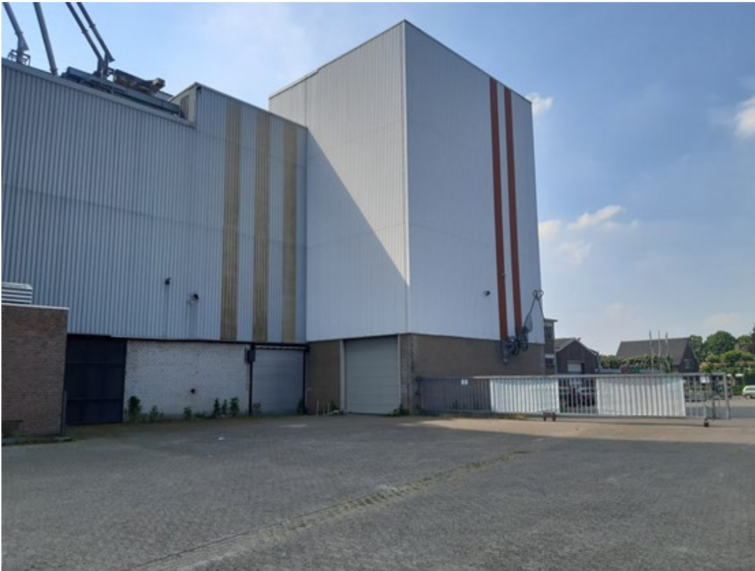
Voormalige fabrieksgebouwen gezien vanuit zuidoostelijke richting
