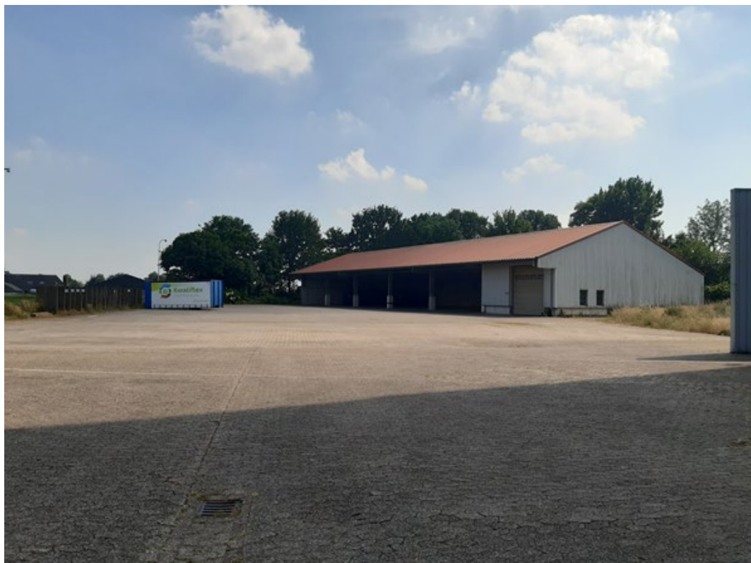
Schuur aan zuidzijde van het plangebied, gezien vanuit noordelijke richting
