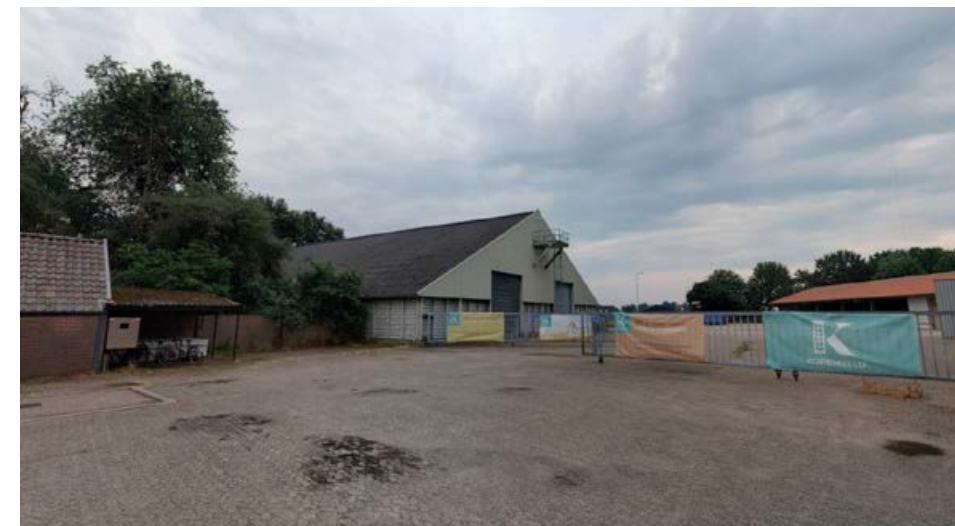
Afbeelding 7: Loods op oostzijde terrein
