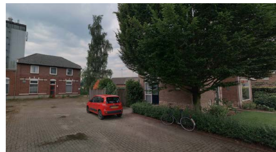
Afbeelding 9: Het gebouw (te slopen) tegen de locatie
