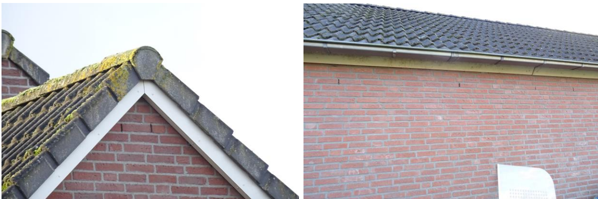
Afbeelding 9 en 10: Aangrenzende bebouwingen met open stootvoegen. Bron: BNL Advies Datum: 17-02-2022
