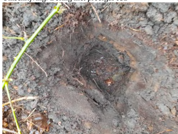
Fotonummer: 10 Omschrijving: Boring met proefgat 015
