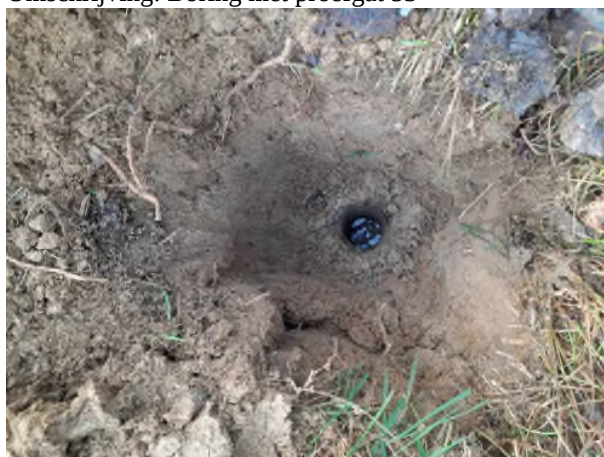
Fotonummer: 28 Omschrijving: Boring met proefgat 035
