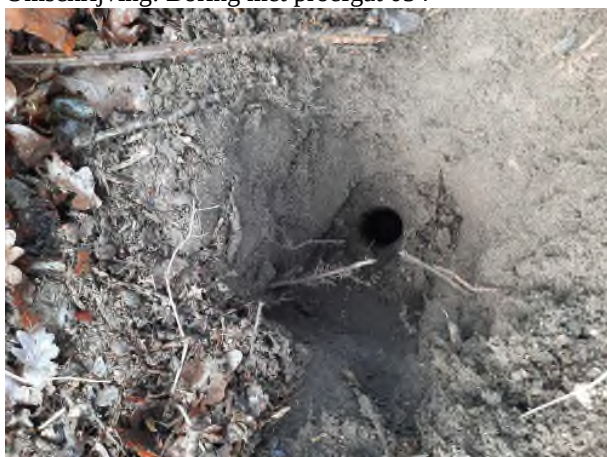
Fotonummer: 27 Omschrijving: Boring met proefgat 028
