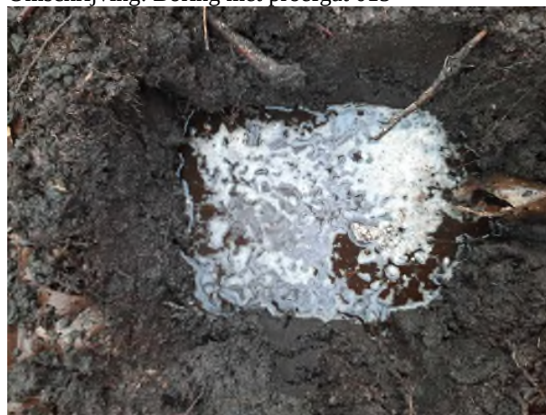
Fotonummer: 12 Omschrijving: Boring met proefgat 009
