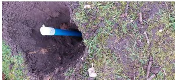
Fotonummer: 26 Omschrijving: Boring met proefgat 53
