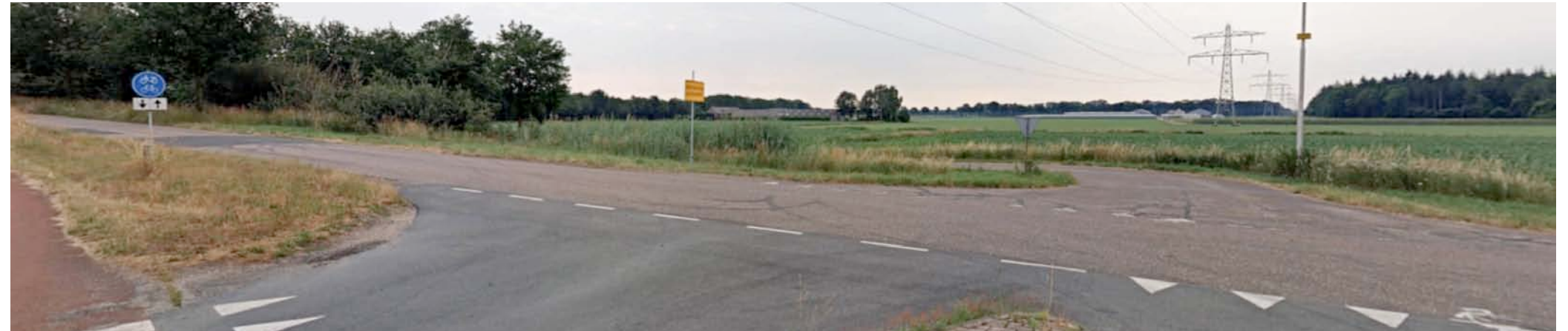
1+2) vanaf opgangen naar de bruggen toont zich de noordwestkant en de zuidoostkant in relatie tot het..
