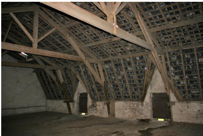
Figuur 4.4.2. De inpandige schuur heeft een enkelwandig dak en steenuilennesten zijn dus zeker afwezig.
