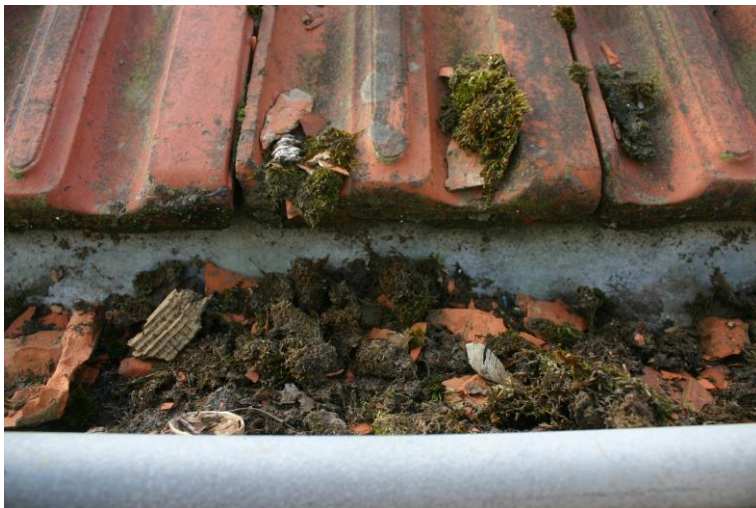
Figuur 4.2.1. Het dak van het bijgebouw bevat vlakke mulden dakpannen waardoor vogels geen toegang hebben tot onder de dakpannen.
