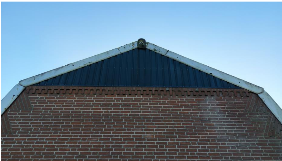
Figuur 4.2.4. De zijgevels van het bijgebouw bevatten een windveer, en aan de bovenzijde een gladde gevelbekleding van damwandplaten waardoor vogels en vleermuizen hier geen toegang hebben.
