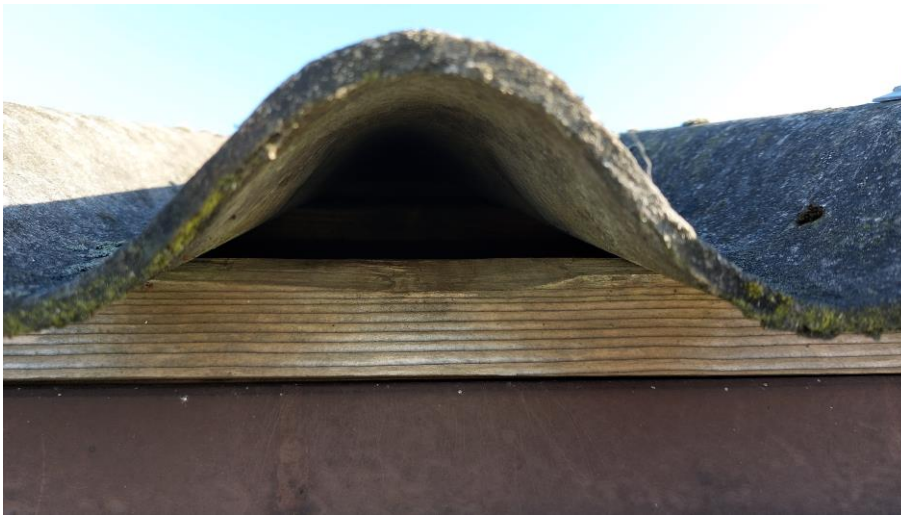
Figuur 4.2.1. Onder de golfplaten van de showroom is geen vogelschroot aanwezig. Huismussen kunnen hier onder nestelen.
