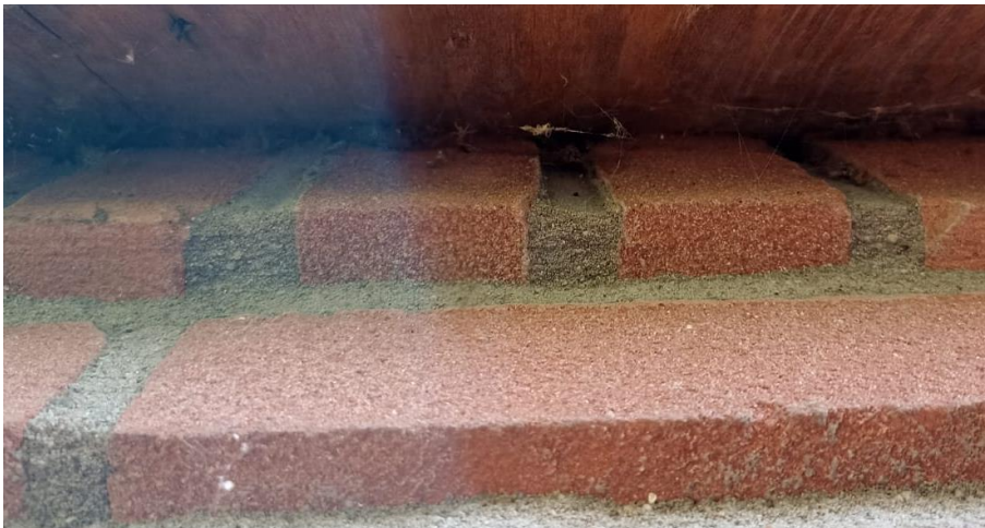
Figuur 4.2.3. Tussen de gevels en het dakoverstek zijn geen spleten die toegang verlenen aan vleermuizen.
