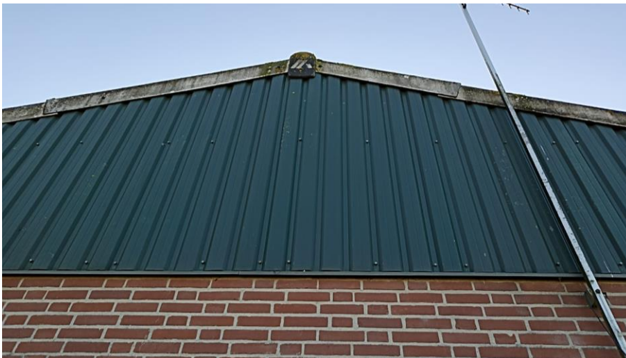
Figuur 4.2.2. De zijgevels van de showroom bevatten een gladde damwandgevelbekleding waardoor vogels en vleermuizen hier geen toegang hebben.
