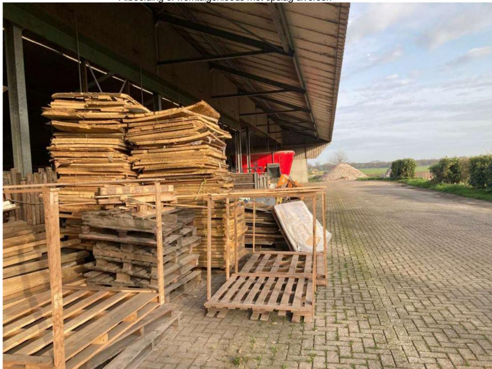
• Afbeelding 6: werktuigenloods met opslag diversen
