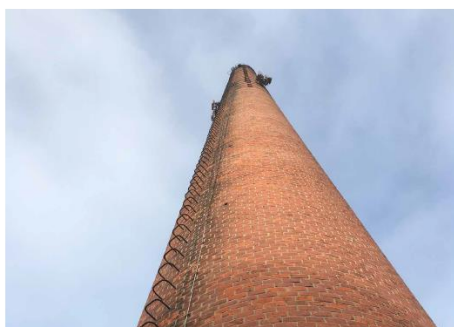
Baksteen gevels die aansluit bij schoorsteen
