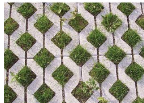
Bestrating half open half dicht tpv infiltratie regenwater en vergroening parkeervakken
