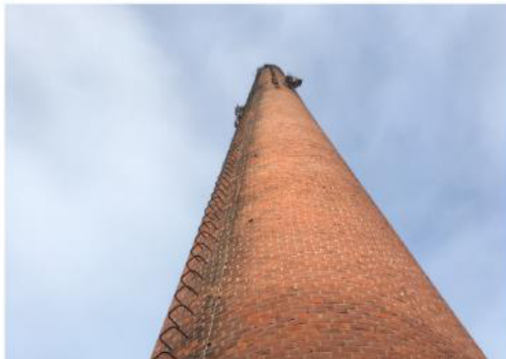
Baksteen gevels die aansluit bij schoorsteen
