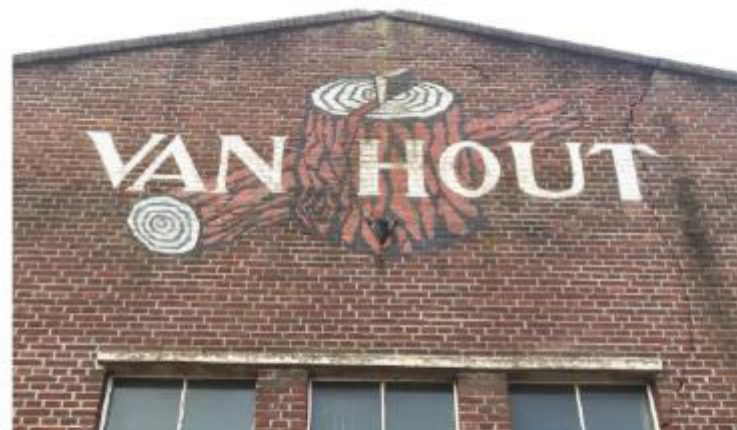
Nieuwe gevel die refereert aan het fabrieksverleden van de houtzagerij
