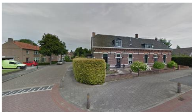
Omliggende bebouwing Spoorstraat 32 & 34
