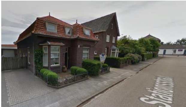
Omliggende bebouwing Stationsstraat 29 & 31
