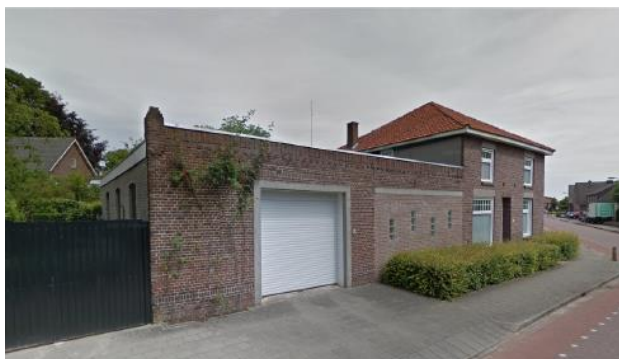
Omliggende bebouwing Spoorstraat 28
