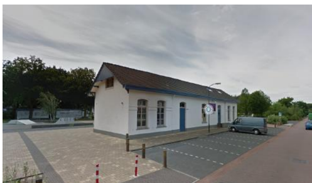
Omliggende bebouwing Spoorstraat 41
