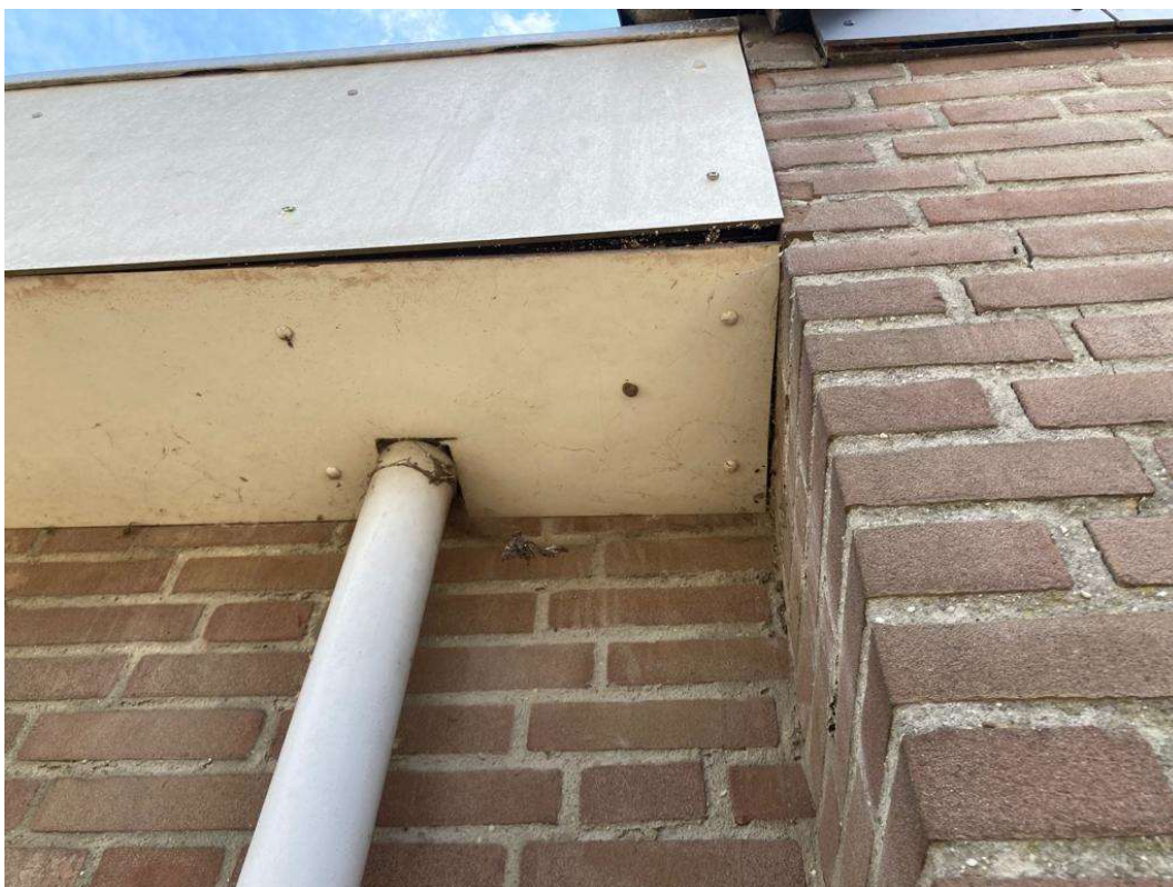
• Afbeelding 6: Trespabepaling met spleet voorzien van spinnenwebben
