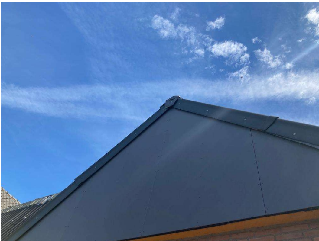
• Afbeelding 5: Boeihoord geheel dicht
