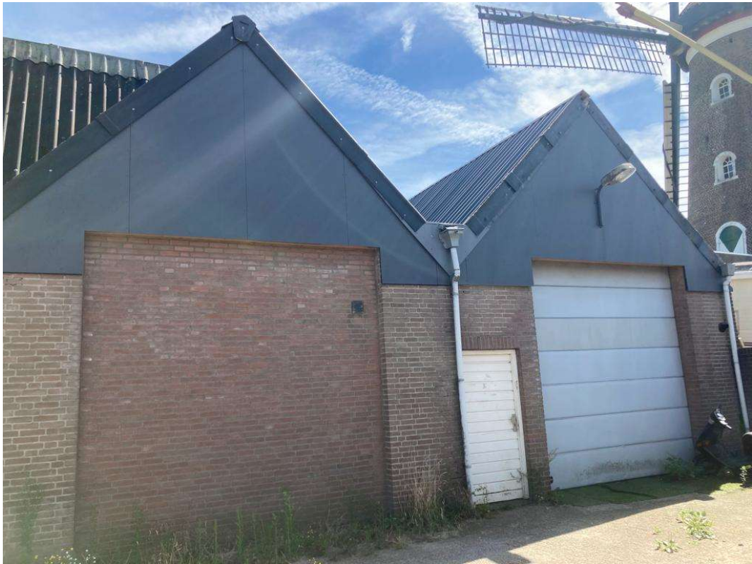
• Afbeelding 3: Zijgevel molenstraat 60 gevel bekleding en dak
