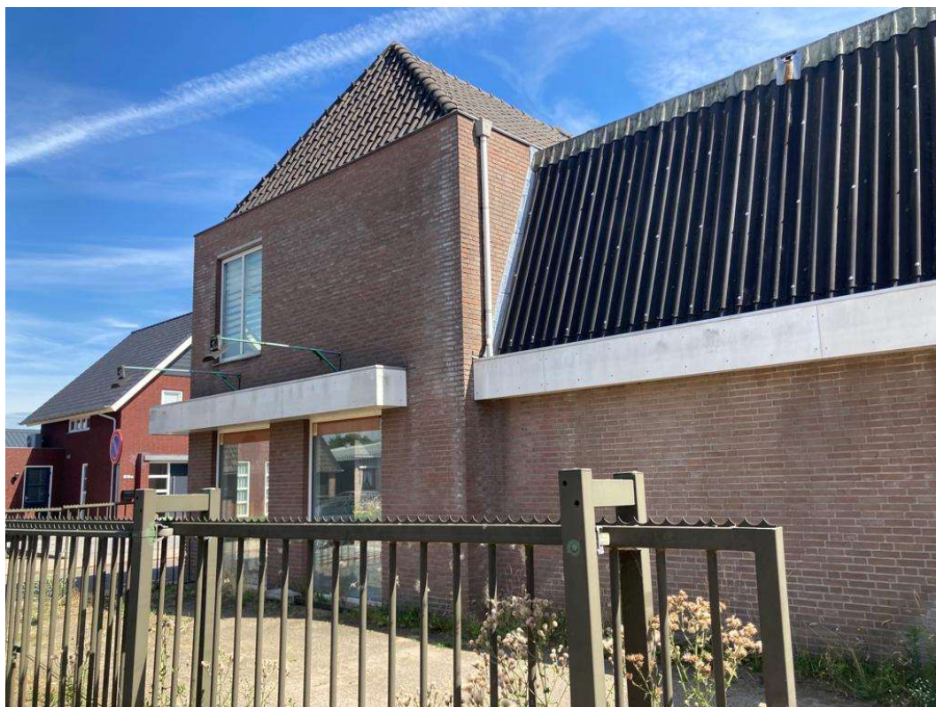
• Afbeelding 11: Voorzijde gevel
