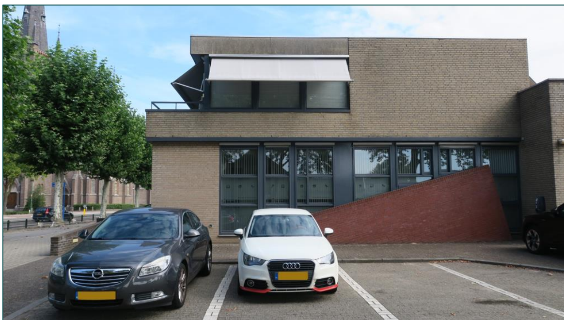
Figuur 4 De zuidzijde van de bebouwing.
