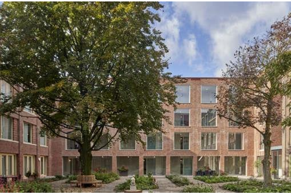
Klooster Oude Dijk Tilburg: voorbeeld van gevels in baksteen, afstemming tussen de verdiepingen bij de gevelindeling
