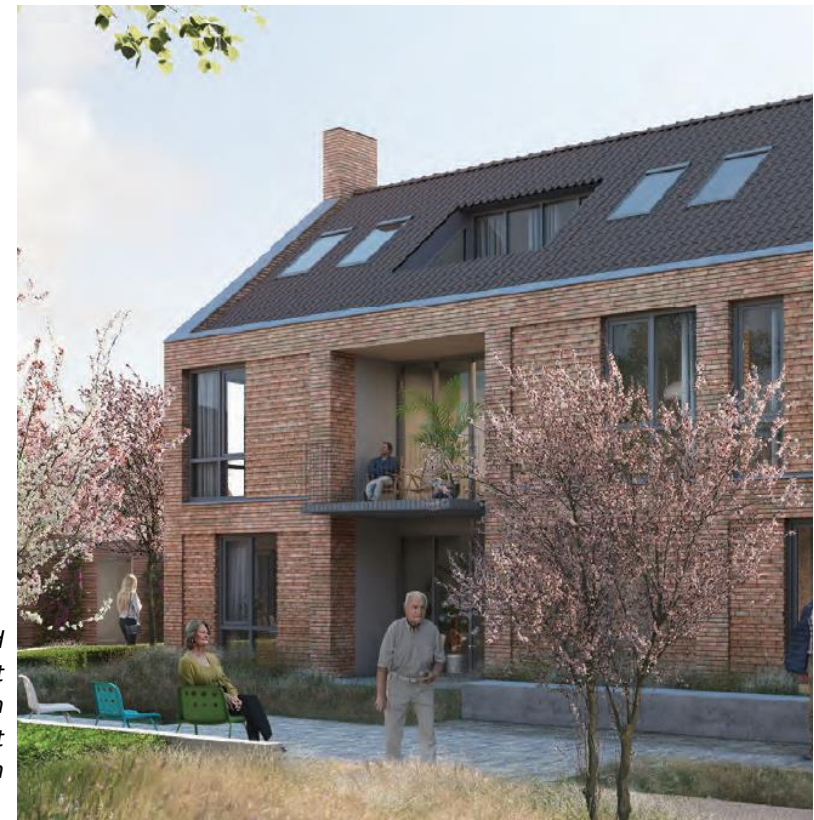
Hof van Zetten: Goed voorbeeld balkons die het dakvlak minimaal verstoren en gevel detaillering met fraaie metselverbanden
