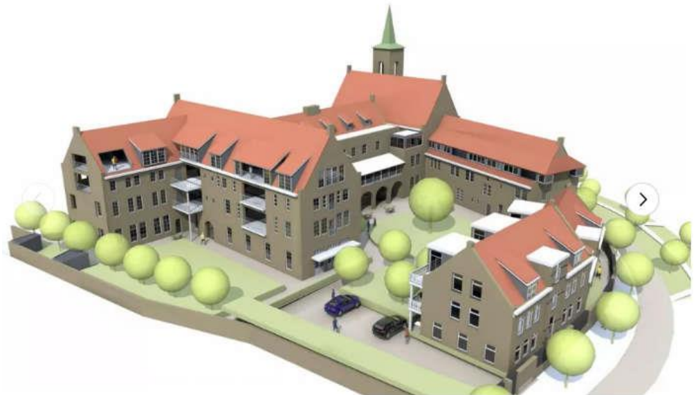
Voorbeeld klooster (Ad Fontes Ootmarsum): Hoofdmassa uitgebreid met verschillende bouwdelen. Kappen voornamelijk zadeldaken en schilddaken
