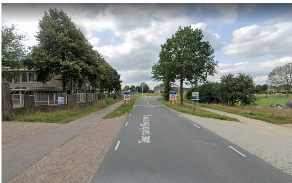
Wegprofiel de Generaal de Bonsweg richting het westen (bron: Google.nl)
