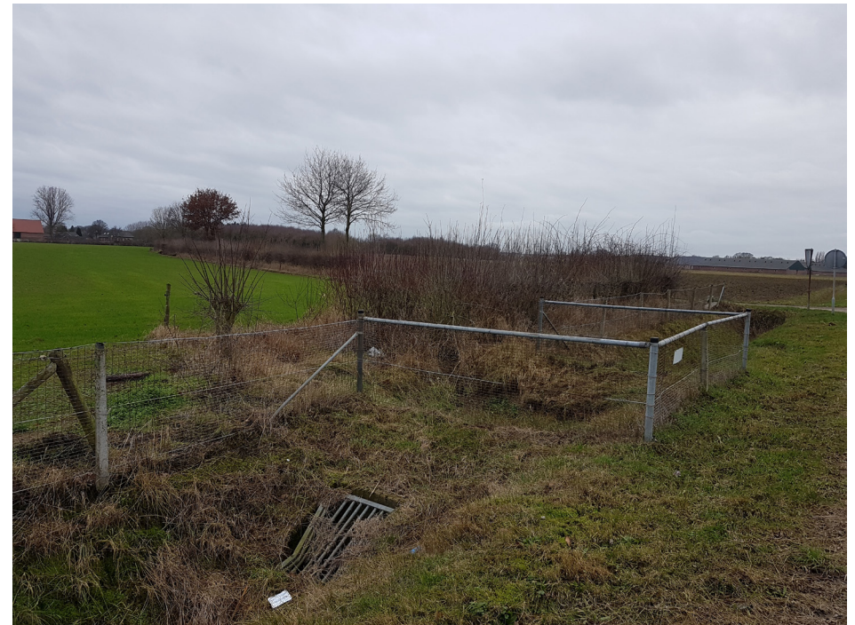
figuur 9: Bestaande dassentunnel
