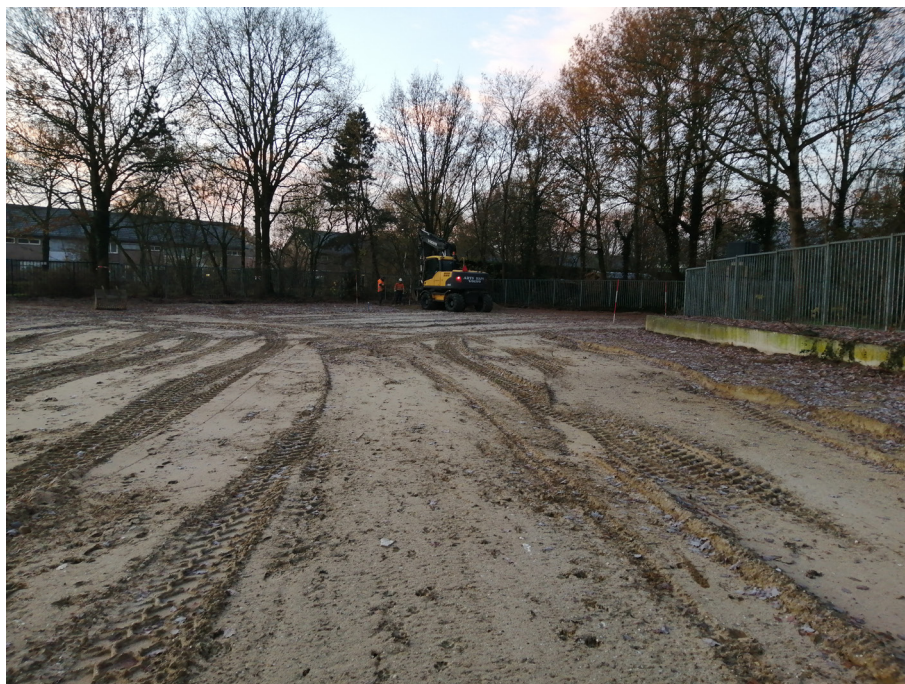
Afbeelding 2.9 Impressie van het veldwerk bij aanvang van de werkzaamheden.
