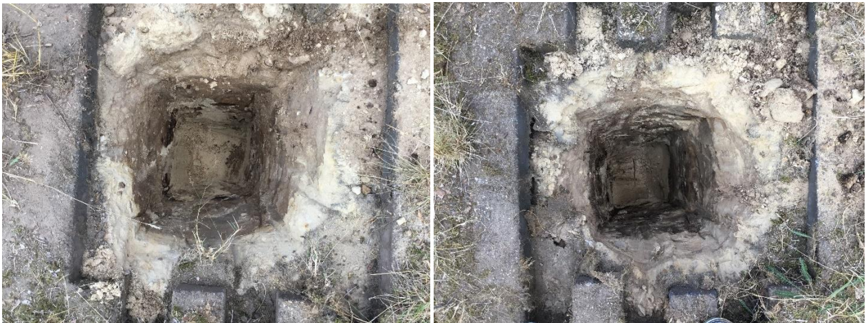
Afbeelding 4.3: Inspectiegaten ter plaatse van de bestaande oprit.
