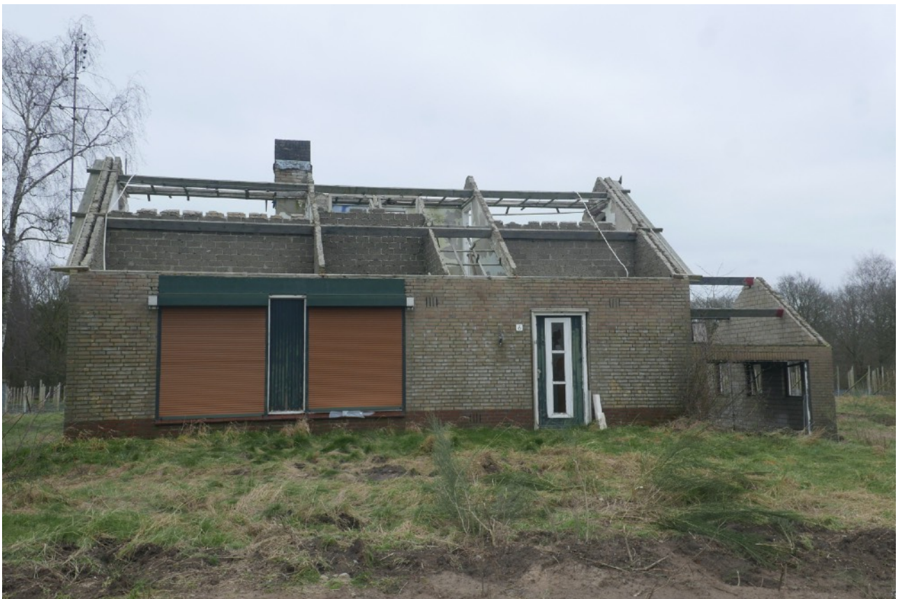
Afb.3: Impressie van het voormalig woonhuis. Zichtbaar zijn brede en geëxposeerde spouwmuren. Geen mogelijkheden voor verblijfplaatsen van vleermuizen.
