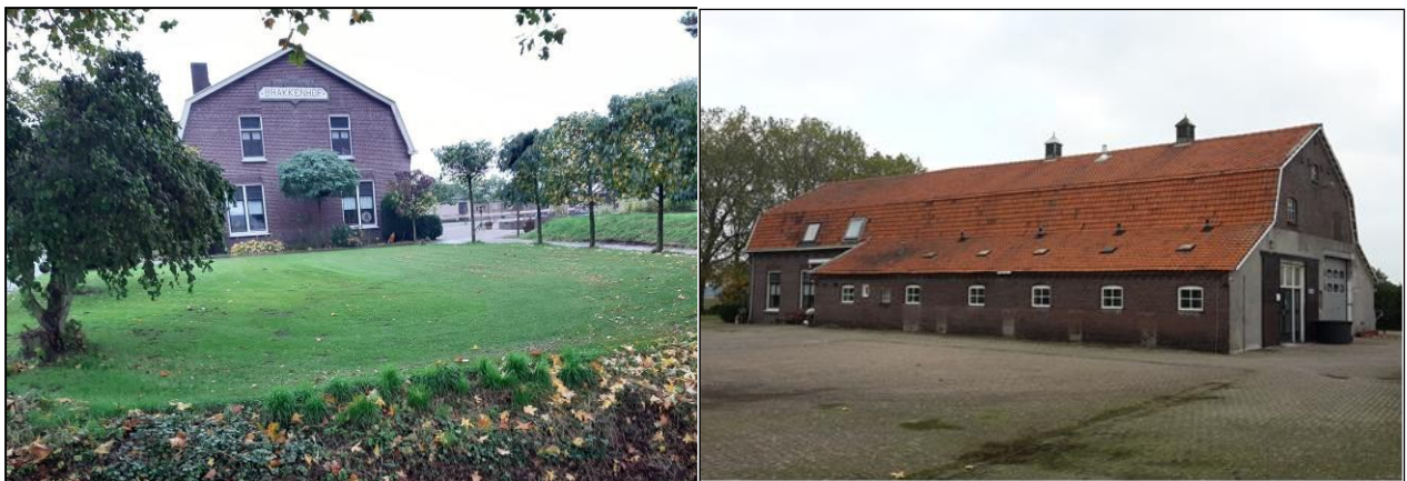
Figuur 4: Zicht op de boerderij Brakkenhof (voor- en rechterzijde)
