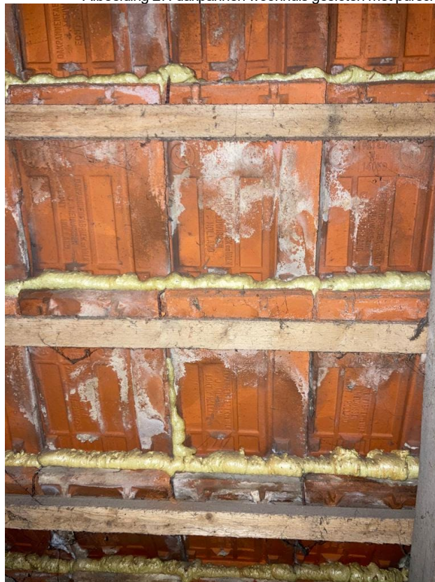
• Afbeelding 27: dakpannen woonhuis gesloten met purschuim
