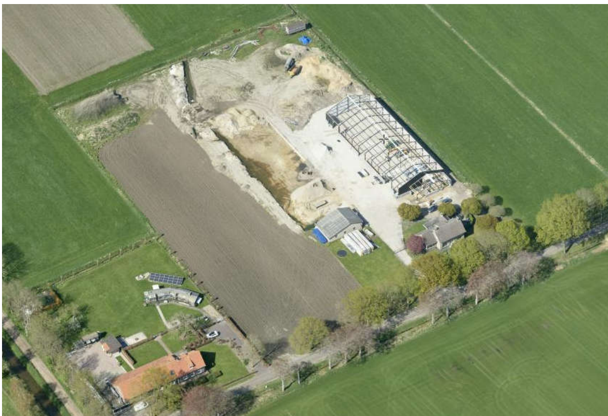
Luchtfoto van de planlocatie in huidige situatie, na sloop van de varkenshouderij
