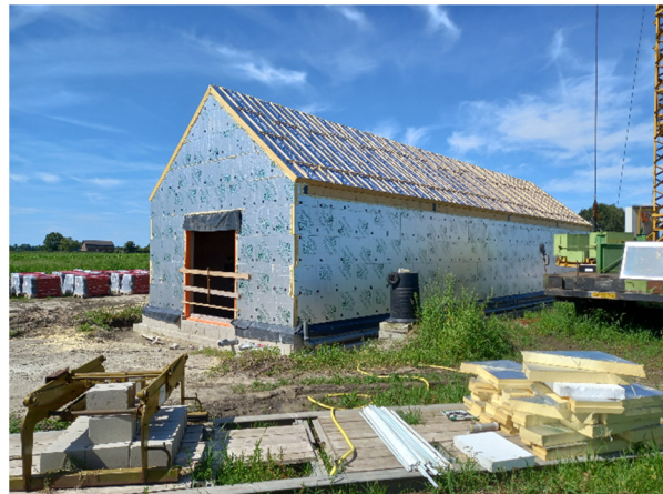
Fig. 2.10 Oploo-Watermolenstraat/Loonseweg. Foto van de nieuwbouw ten zuidwesten van boring 24. Foto genomen tijdens het veldonderzoek op 14 augustus 2023 ten zuidwesten van de locatie van boring 24 (zie bijlage 13) richting het noordwesten.
