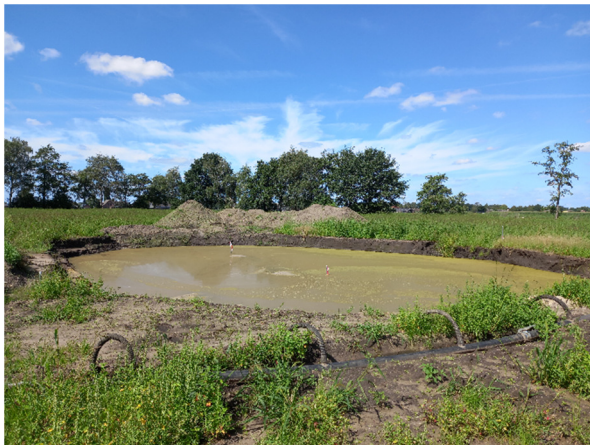
Fig. 2.9. Oploo-Watermolenstraat/Loonseweg. Foto van de afgraving tussen boringen 14, 17 en 18. Foto genomen tijdens het veldonderzoek op 14 augustus 2023 ten noordwesten van de locatie van boring 17 (zie bijlage 13) richting het noordwesten.
