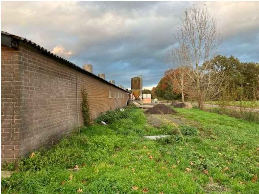
• Afbeelding 11: Rechter zijgevel rechtse stal met naastliggend terrein en oprit naar achter
