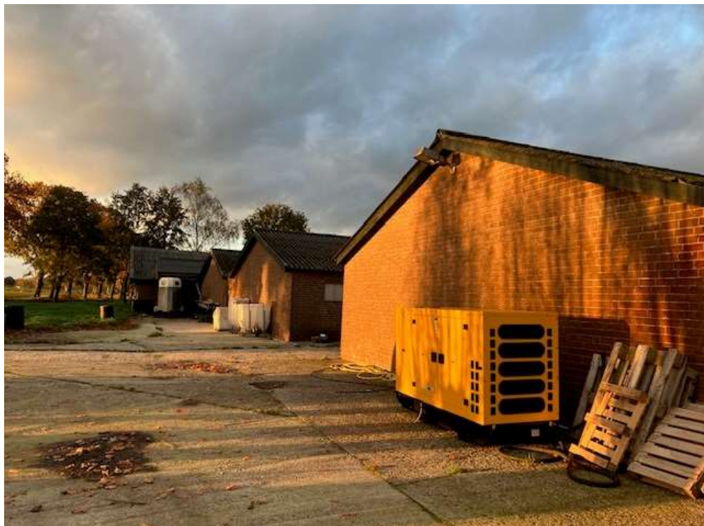
• Afbeelding 4: Erf aan de voorzijde van de stallen, verhard, verlichting tegen de gevel
