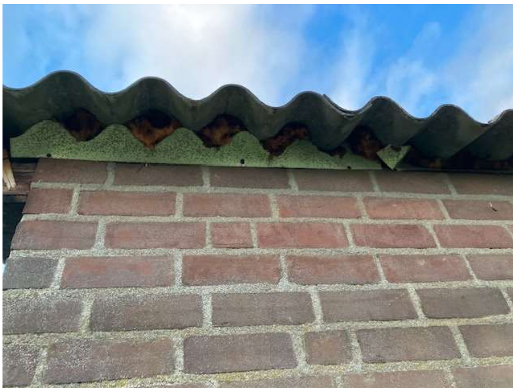
• Afbeelding 13: Onderzijde dak, voorzien van openingen vogelschroot en pur
