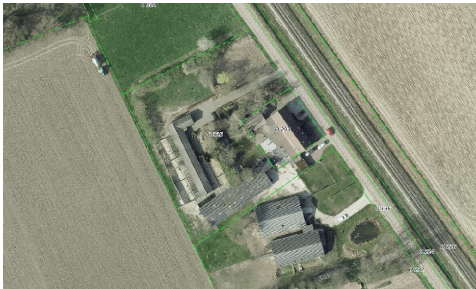
Luchtfoto huidige situatie
