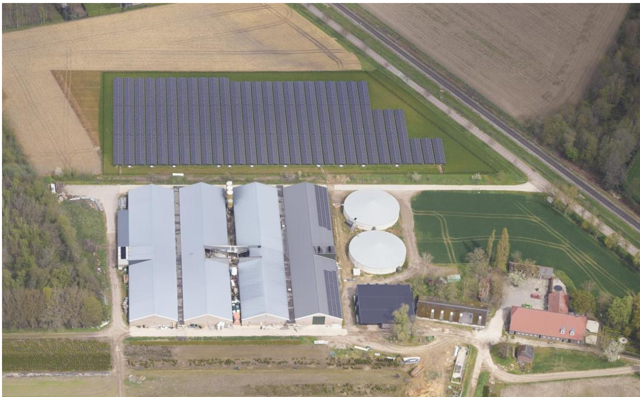
Luchtfoto huidige situatie
