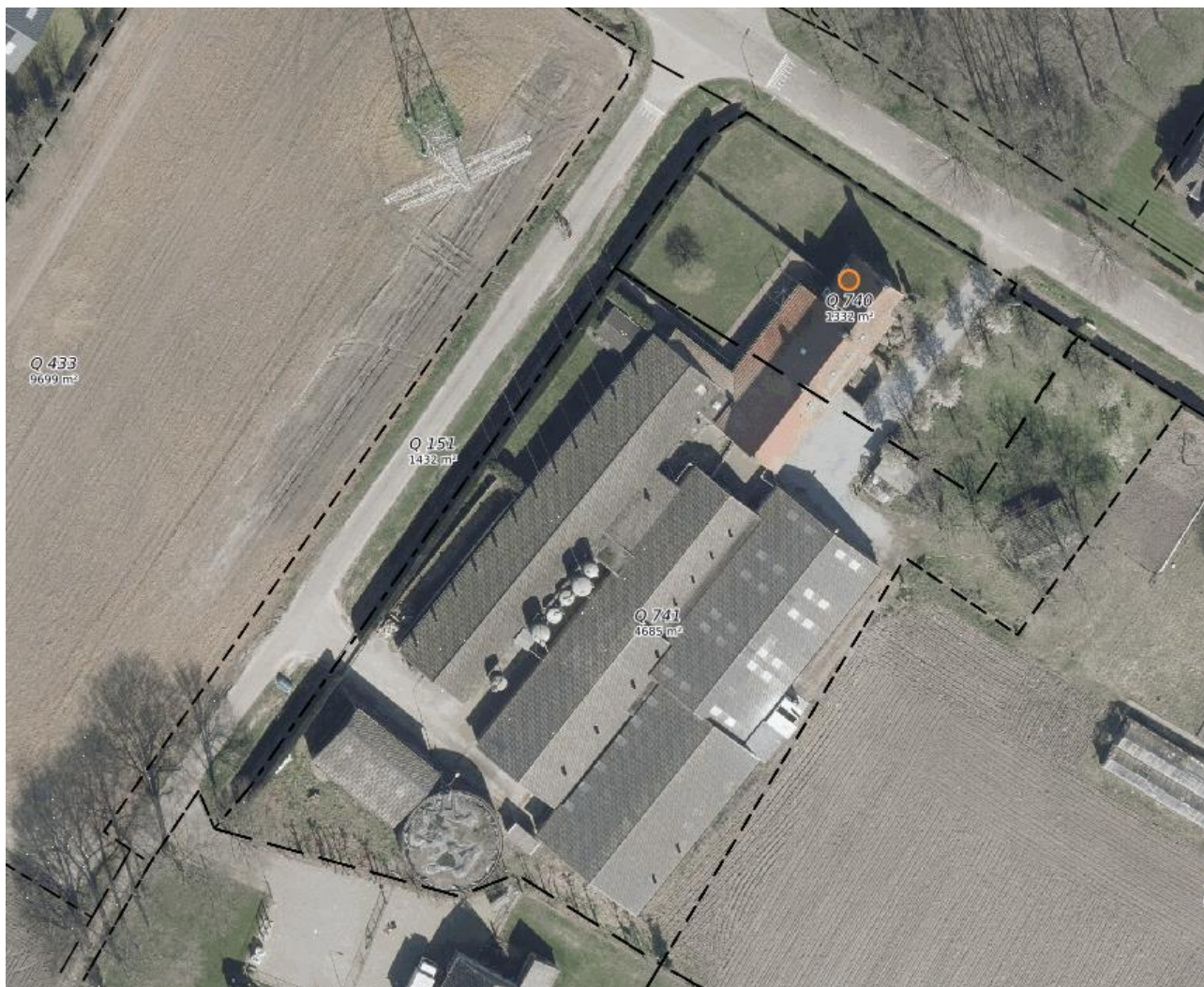
Figuur 9. Luchtfoto Rondweg 20
