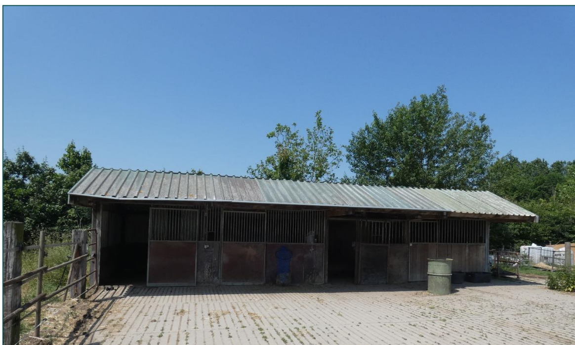
Figuur 2 De bebouwing bestaat uit damwandplaten en golfplaten.
