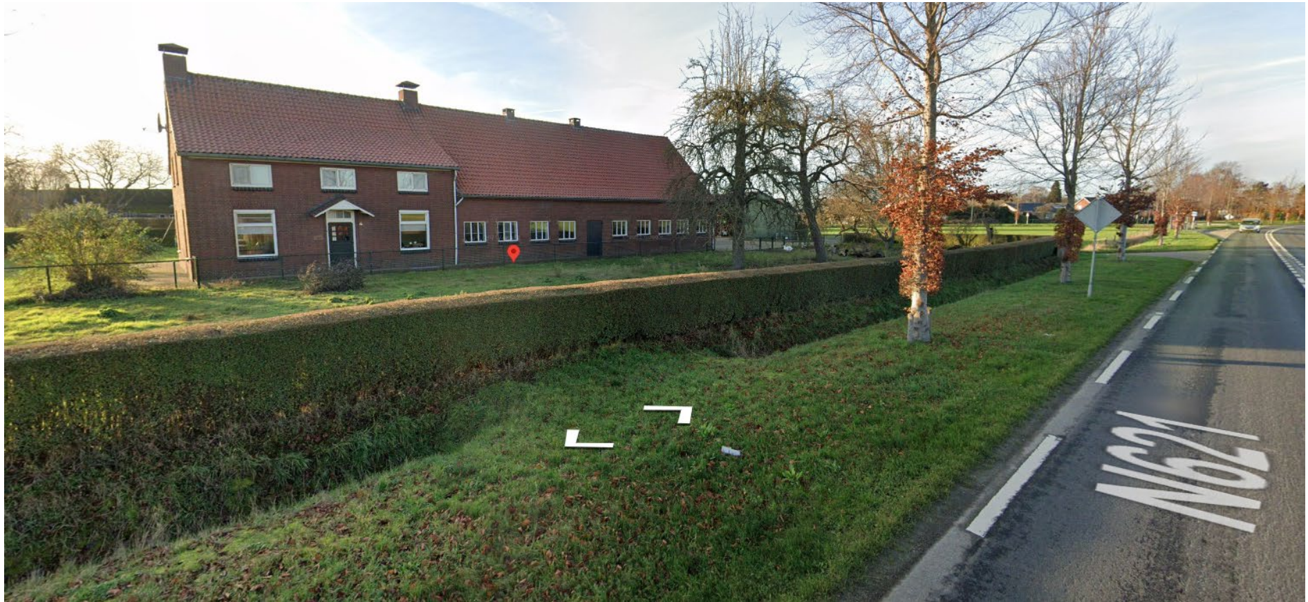
Aanzicht voorzijde boerderij vanuit oostelijke richting, woning met aangebouwde staldeel. Gekoppelde bouwmassa: woning en staldeel, afzonderlijk in symmetrie
