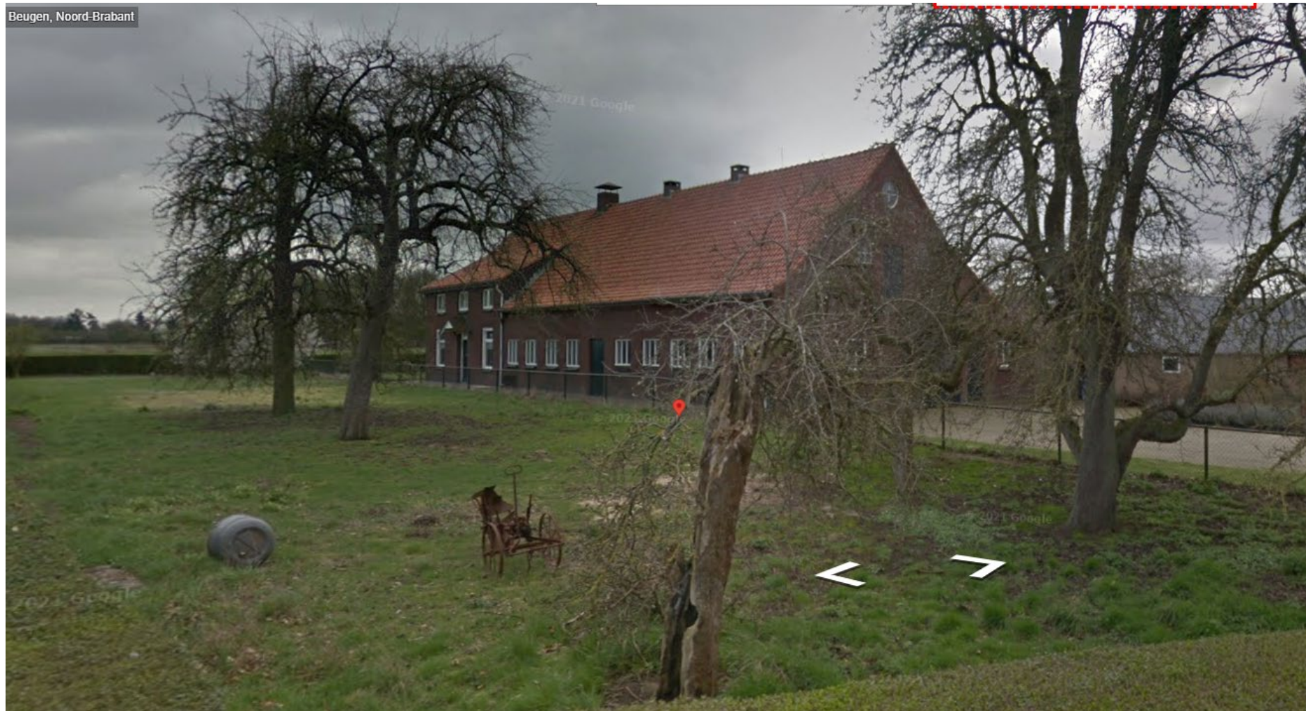
Aanzicht boerderij en voortuin (omhaagd en met fruitbomen) vanuit noordelijke richting. Symmetrie staldeel en met onderbroken dakvlakken
