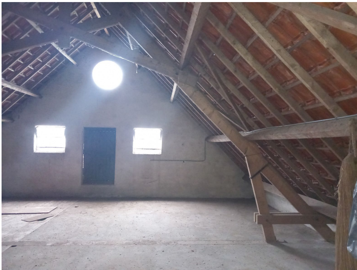
Oorspronkelijke kapconstructie met gebinten
