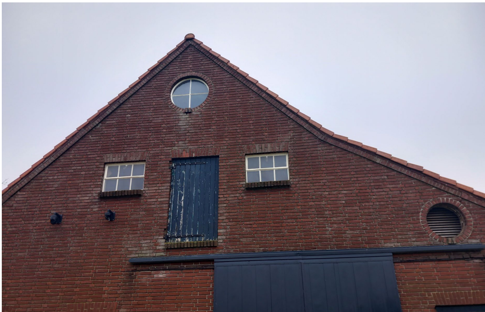
Zicht op de noordelijke gevel (hooizolder met typerend hooiluik en raampartijen) en het onderbroken dakvlak
