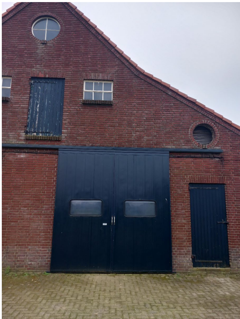
Noordelijke gevel met zicht op hooizolder met luik en raampartijen (gemoderniseerde staldeur)
