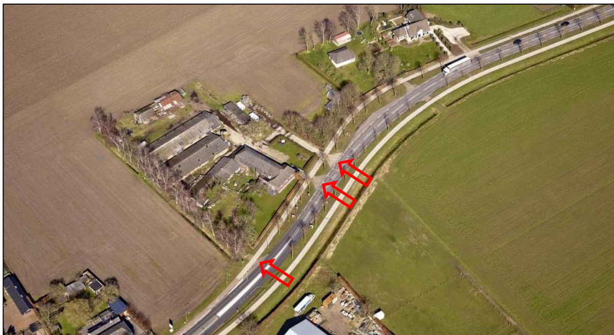
Afbeelding 22: Uitsnede luchtfoto met aanduidingen de drie bestaande ontsluitingen (rode pijlen)
