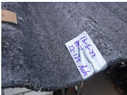
Foto 1 M01 dak opstal 1
