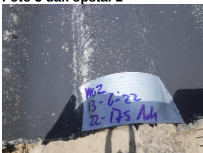
Foto 5 M02 dak opstal 2
