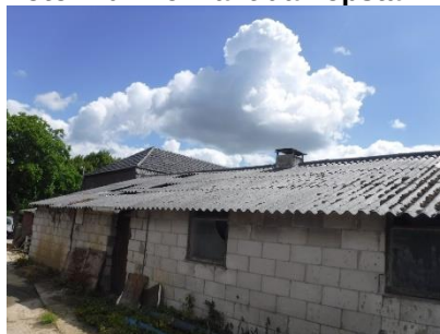
Foto 4 dak en dak koker opstal 1
