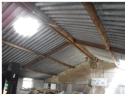
Foto 2 binnenkant dak opstal 1
