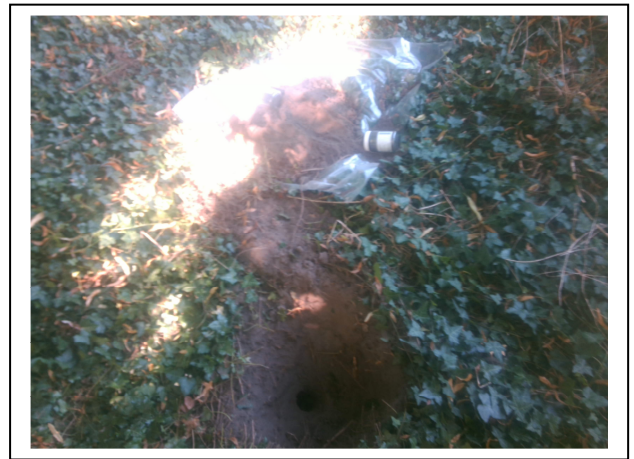
Foto 30. Asbestinspectiegat B13
