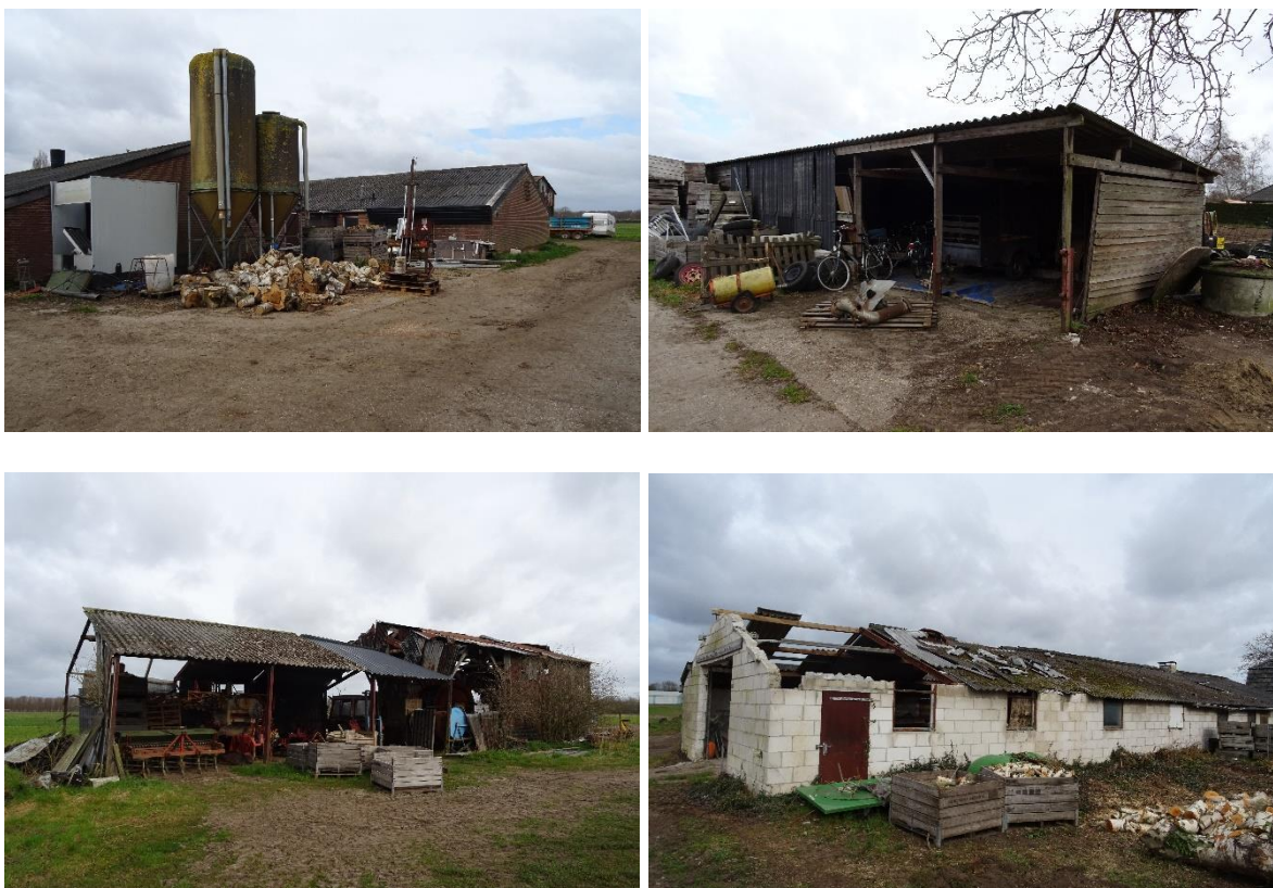
Afbeelding 3 t/m 6: te slopen bebouwing. Bron: BNL advies. Datum: 17-03-2022
