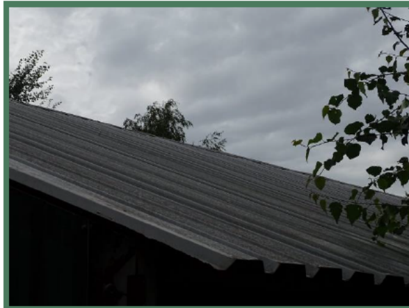
Overzicht dak oostelijke shed
