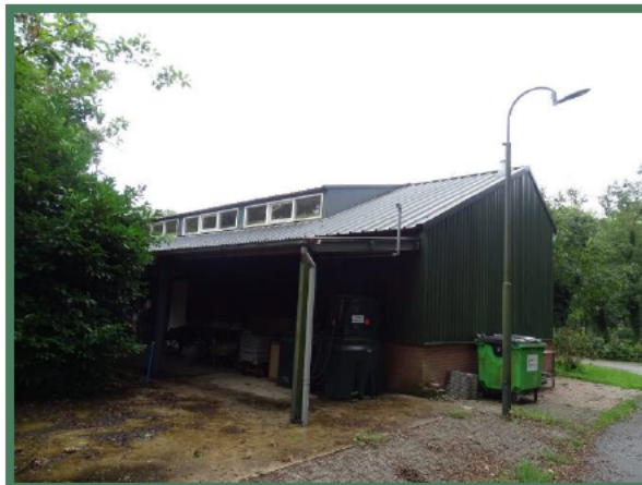
Overzicht inpandig te verbouwen schuur
