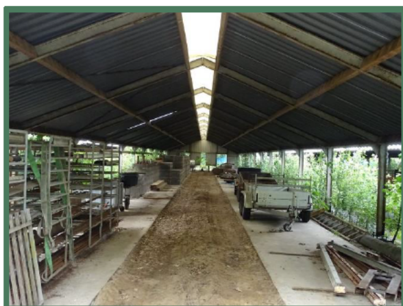
Overzicht oostelijke shed in gebruik als opslag
