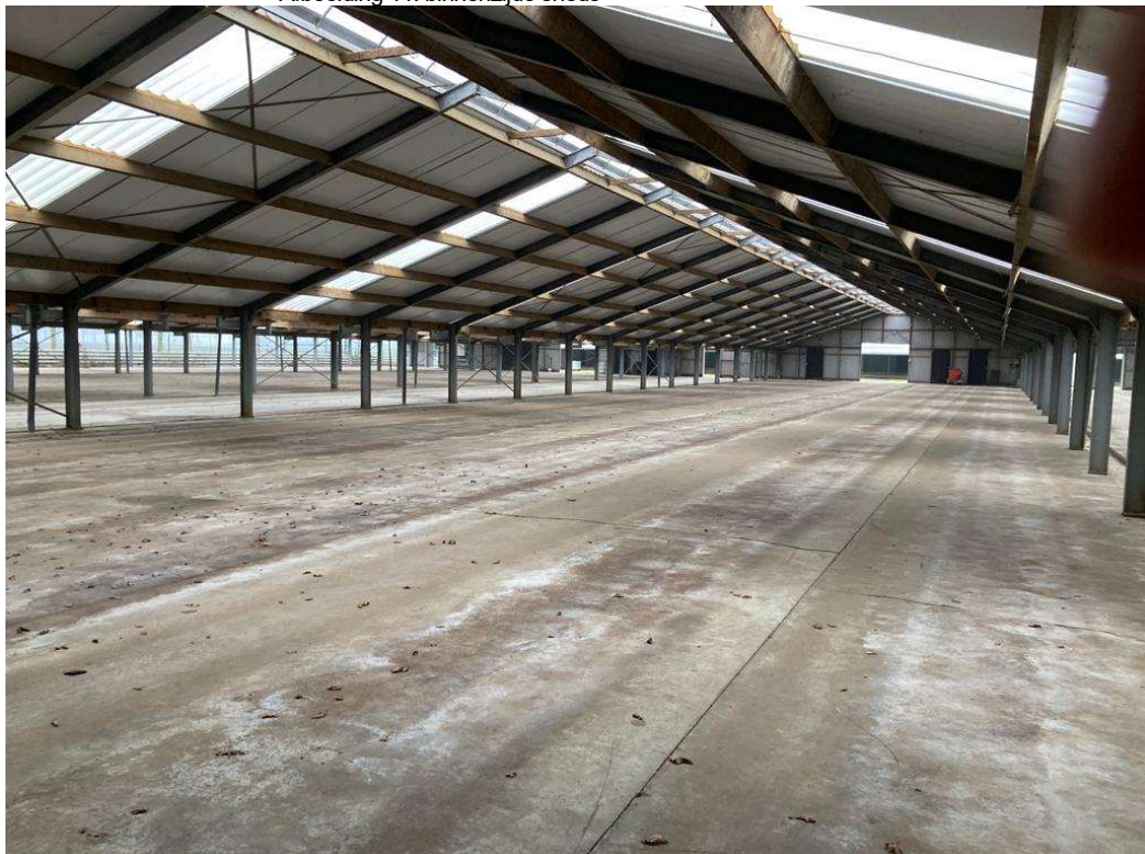
• Afbeelding 11: binnenzijde sheds
