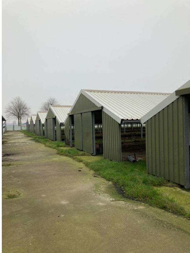
• Afbeelding 14: buitenzijde sheds
