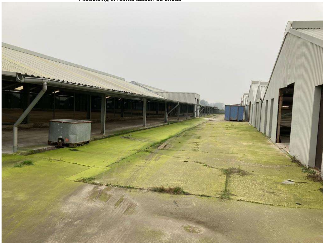
• Afbeelding 9: ruimte tussen de sheds
