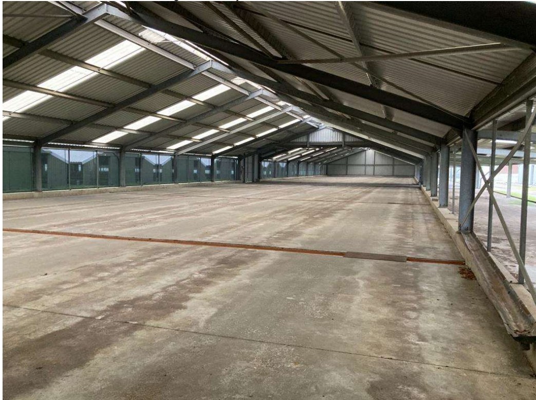
• Afbeelding 10: binnenzijde sheds
