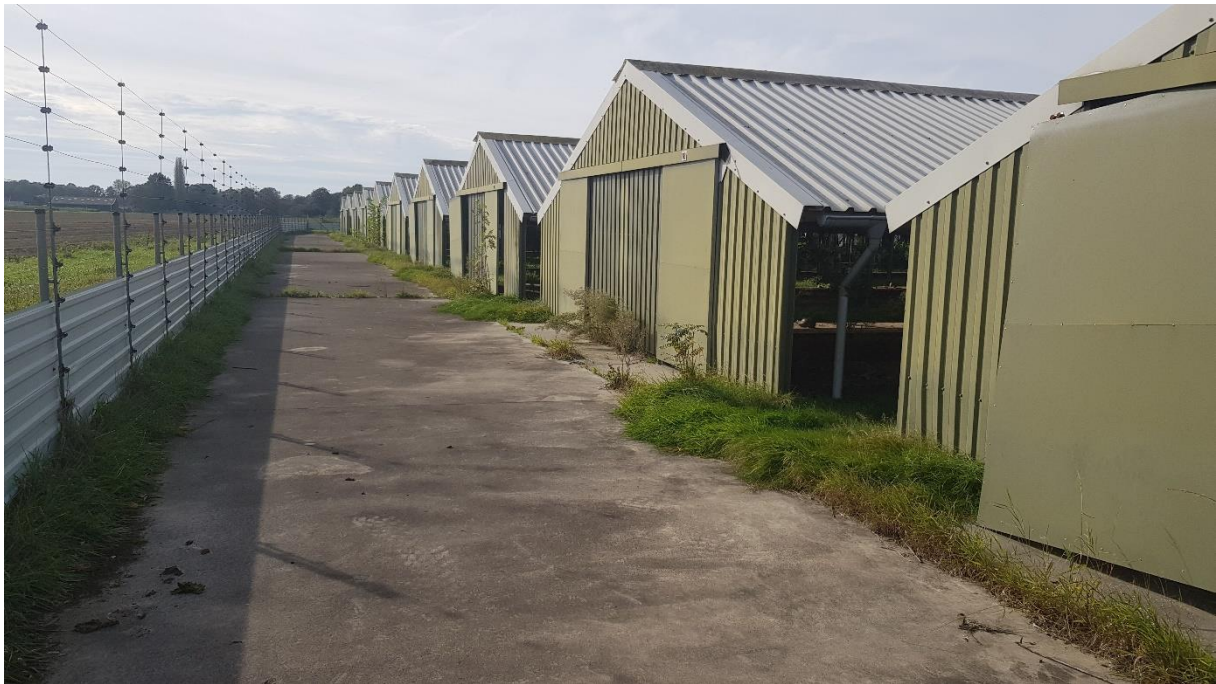
ten zuiden van sheds (6)
