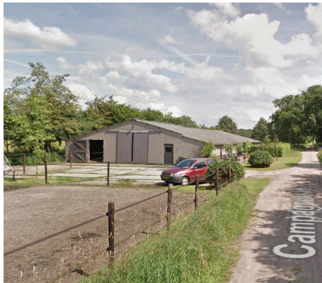
Beeld 2. Voormalige ligboxenstal aan de Campagnelaan
