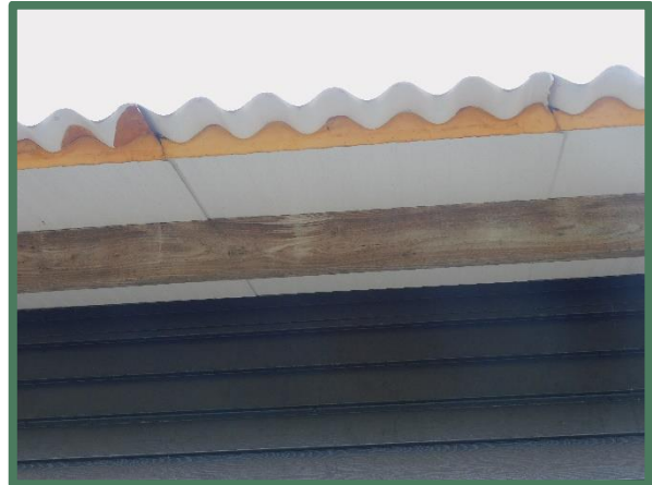
Afgesloten dak en dakrand
