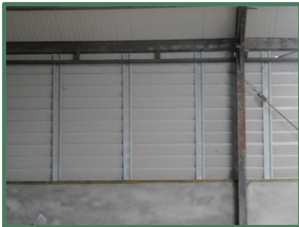
Bovenzijde spouw afgesloten
