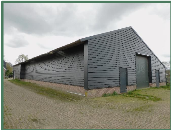
Te slopen voormalige rundveestal
