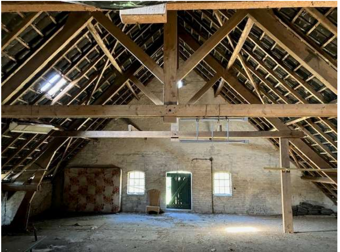
• Afbeelding 20: Zolder van de te slopen bedrijfswoning
