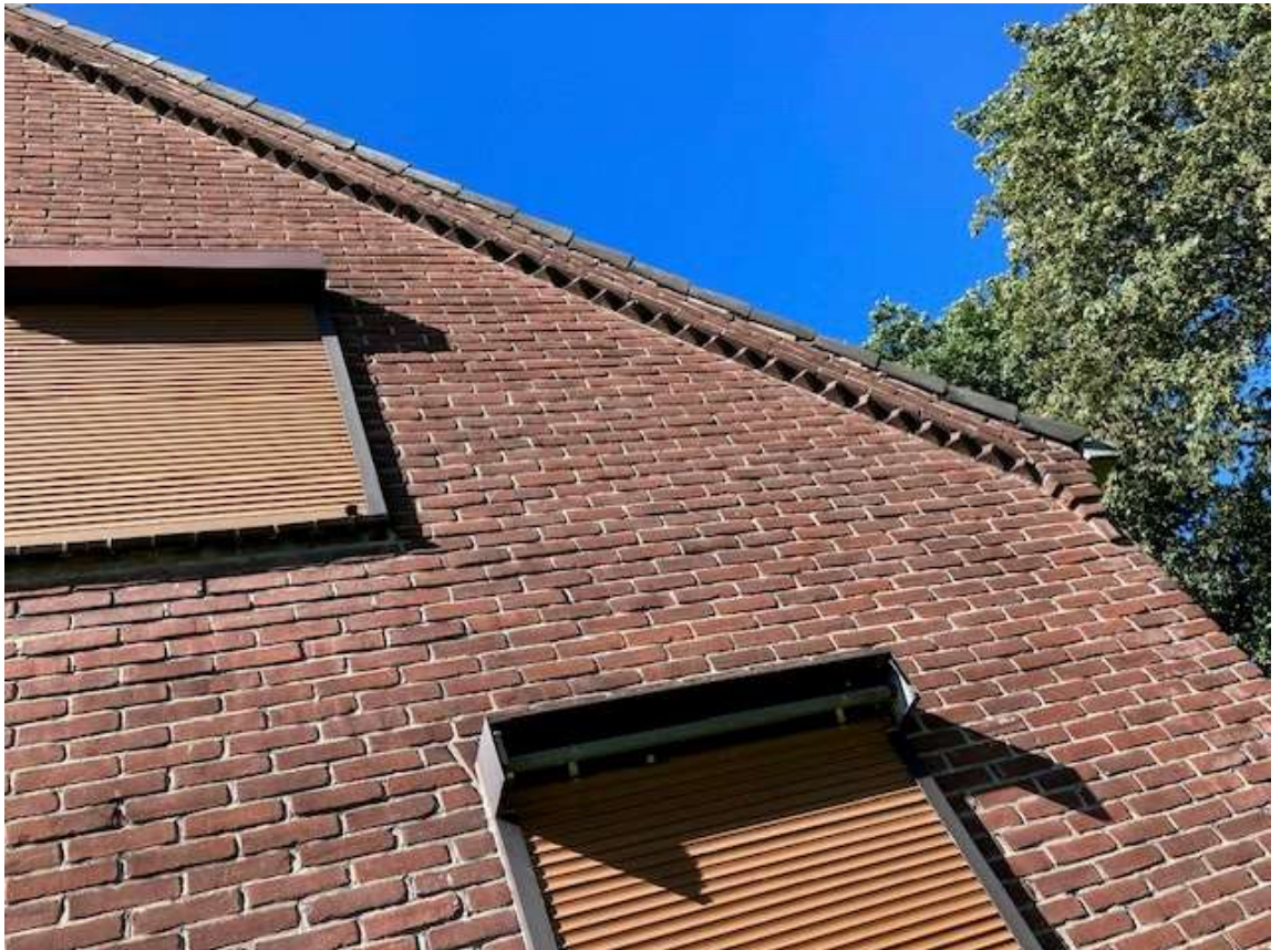
• Afbeelding 22: Dakaansluiting kantpannen, vol met specie.
