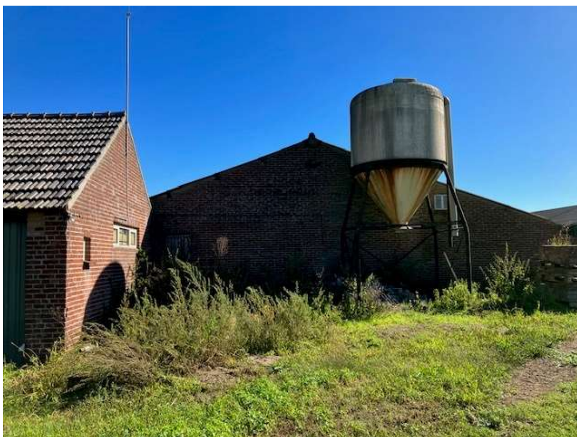
• Afbeelding 17: Achterzijde voormalig ligboxenstal
