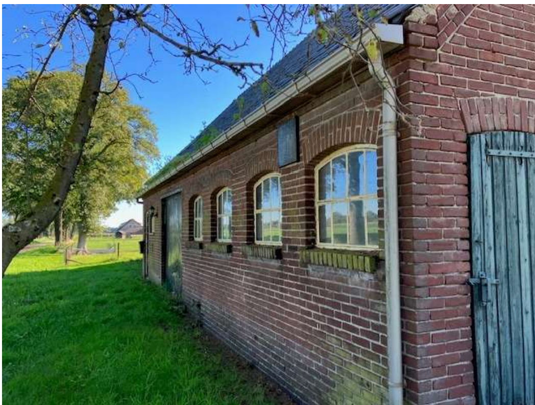
• Afbeelding 26: Zijkant te slopen bedrijfswoning
