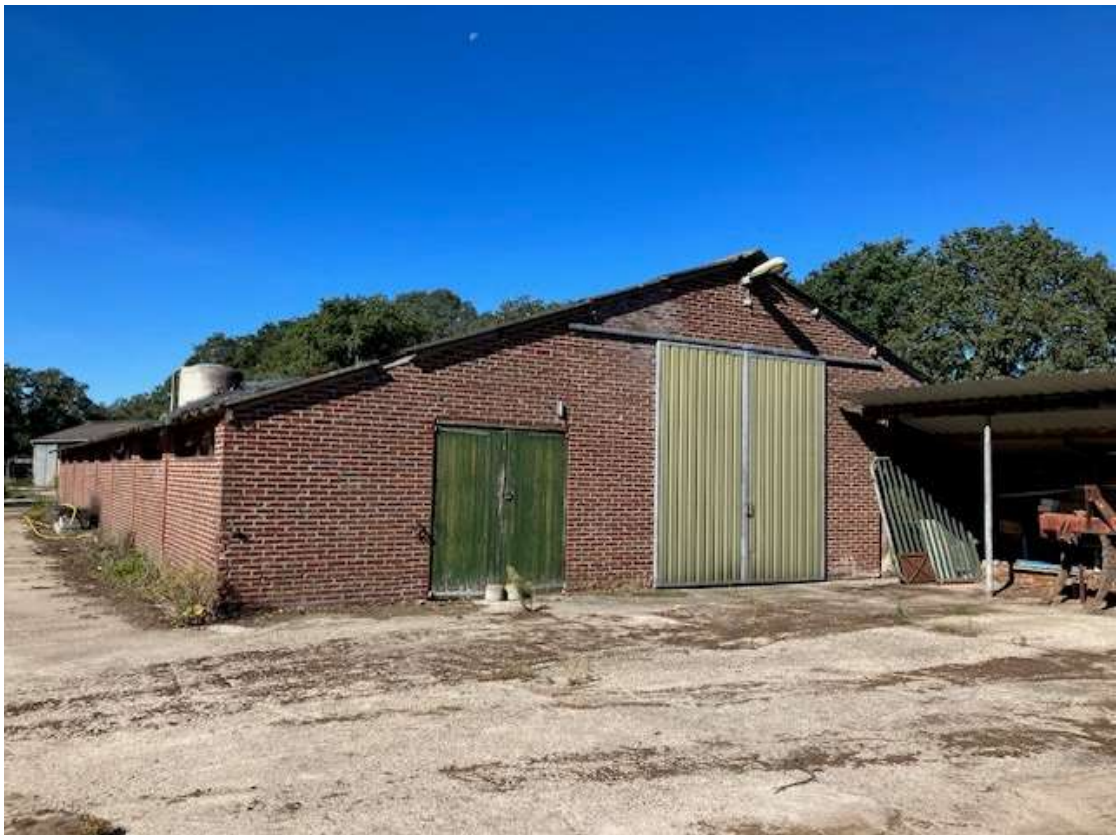
• Afbeelding 15: Voormalig ligboxenstal wordt gesloopt
