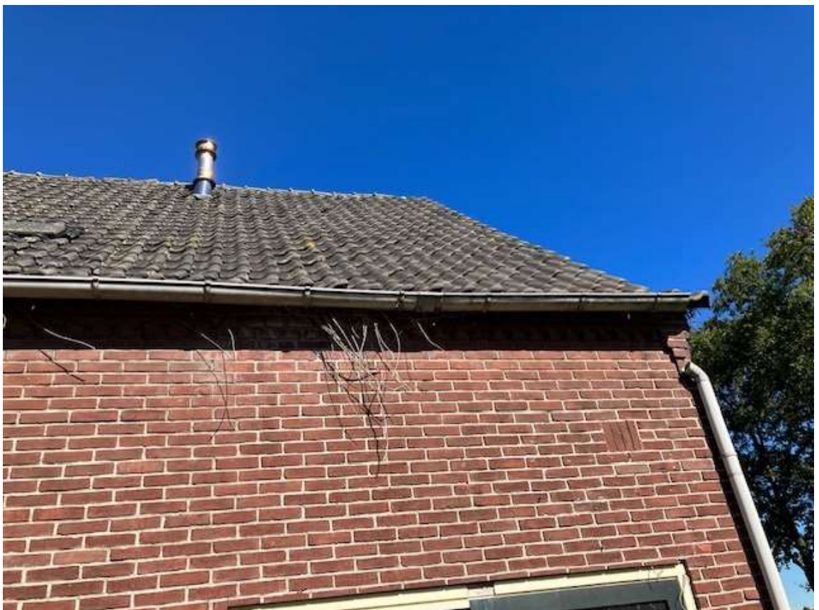
• Afbeelding 23: Dakgoot vol met resten van voormalig klimop
