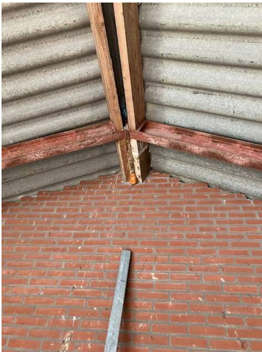
• Afbeelding 9: Bewoond huismussennest in bijgebouw
