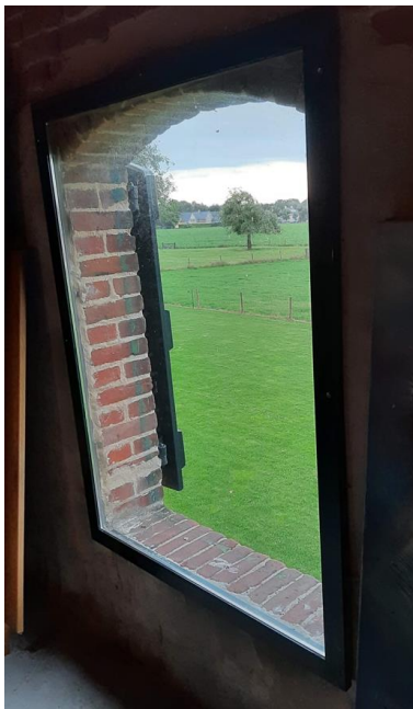
Afbeelding 7. Ramen met slechte naad- en kierdichting
