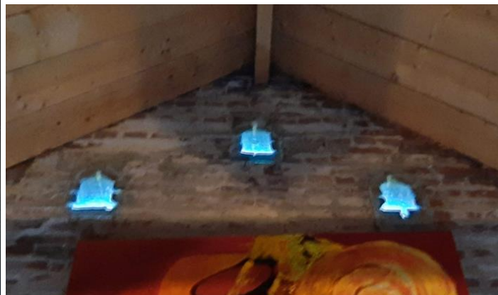
Afbeelding 7. Ramen met slechte naad- en kierdichting
